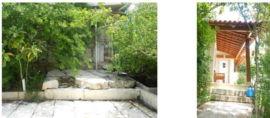
Figura 187A – Cisterna no pátio e Alpendre no Alçado Principal
