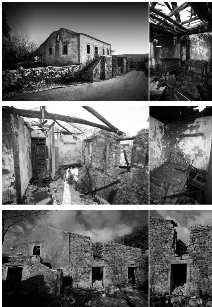
Figura 12A – Estado do edifício após o incêndio referido
