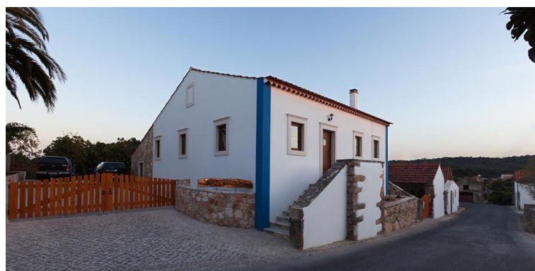
Figura 14A – Aspeto do edifício em 2014 após a reabilitação
