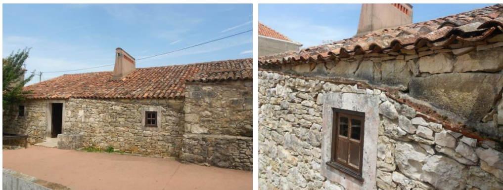
Figura 96A – Pormenor da caleira das águas pluviais no alçado posterior
