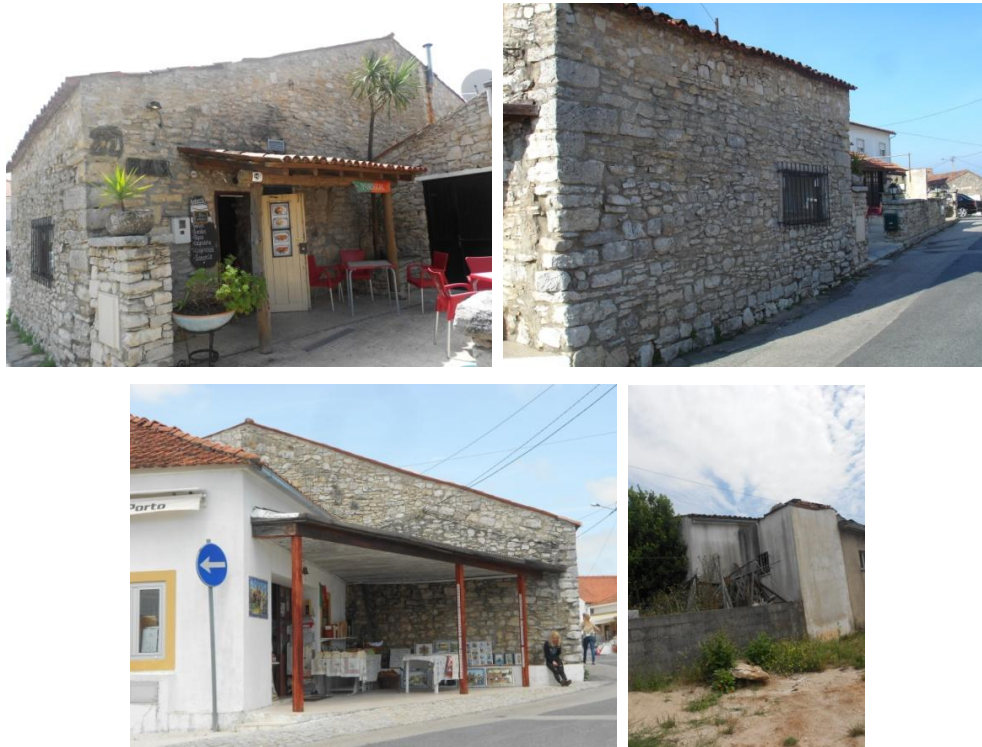
Figura 216A – Varias vistas exteriores do edifício
