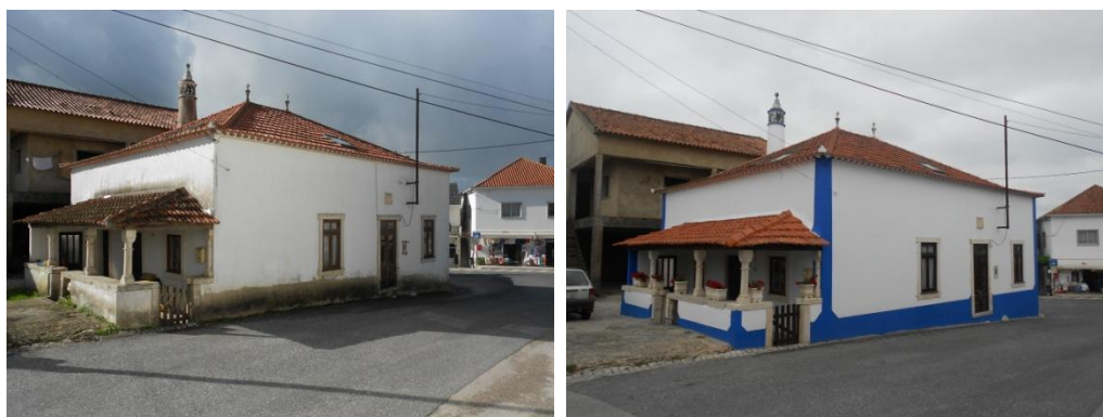
Figura 23A – O edifício em 2014, antes e depois de uma manutenção geral
