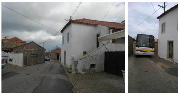
Figura 6A – Estrangulamento da via em frente ao edifício
