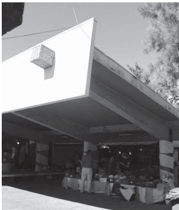
Figura 3. Mercado municipal Vila da Feira, 1953-1959. Fotografía Silvia Cebrián Renedo. Marquesina del mercado en la que las vigas sobresalen del zuncho perimetral de gran expresividad, generando en un espacio a cubierto en el que se ubican los comerciantes.
