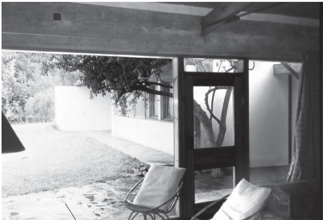
Figura 5. Casa de vacaciones en Ofir, 1957-1958. Fotografía Daniel Villalobos Alonso. Vista desde la sala de estar del patio principal de la vivienda a través del espacio de transición: la varanda . La cubierta de la sala se apoya sobre las cerchas de madera cuyo cordón inferior es un cable de acero a tracción. Estas a su vez descansan sobre una gran viga de hormigón visto, generando un moderno pero a la vez tradicional sistema estructural.
