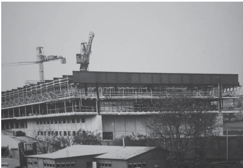
Figura 3. Casa del Cine en construcción. Archivo fotográfico del Instituto del Cine.
