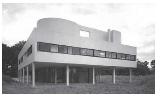
Figura 11. Le Corbusier y Pierre Jeanneret. Villa Savoye (1929-1931). Restauración.
