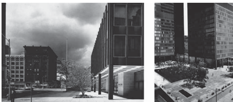
Figura 18. Montaje comparativo entre los dos edificios.
