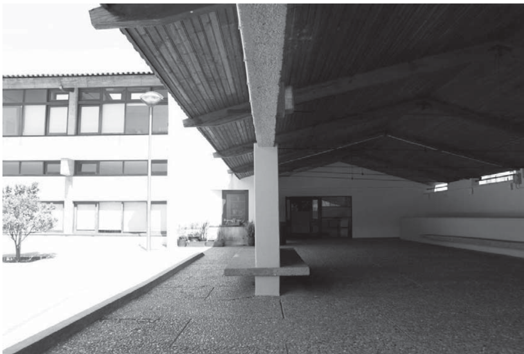
Figura 6. Escuela Primaria del Cedro, 1957-1961. Fotografía Silvia Cebrián Renedo. Perspectiva del patio de recreo cubierto en el que se combina la estructura tradicional de madera y trasdós de listones de madera con el hormigón. Al fondo pabellón de aulas con estudio volumétrico consiguiendo diferentes planos para dar solución al problema del soleamiento.
