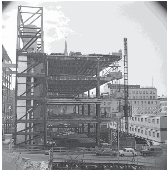
Figura 6. Casa de la Cultura en construcción. Parte Oeste para uso como Parlamento Provisional 19 . Faktarummet Stockholms Stadsmuseum. F85843. Göran Fredriksson, 1969.
