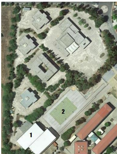
Figura 5 - Vista Aérea- Instalações Desportivas Escola Secundária Dr. Jorge Augusto Correia - Tavira
