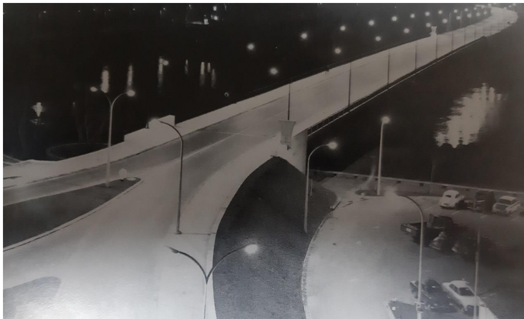
Figura 28 – Vista noturna da Ponte Eng. José Machado Vaz, fonte arquivo municipal CMM
