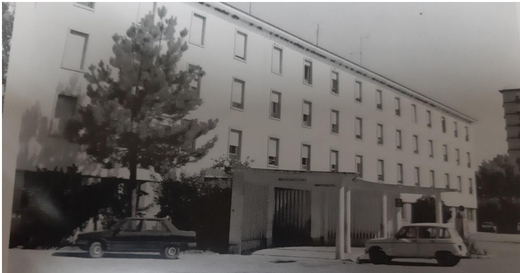
Figura 27 – Hospital distrital de Mirandela, fonte arquivo municipal CMM
