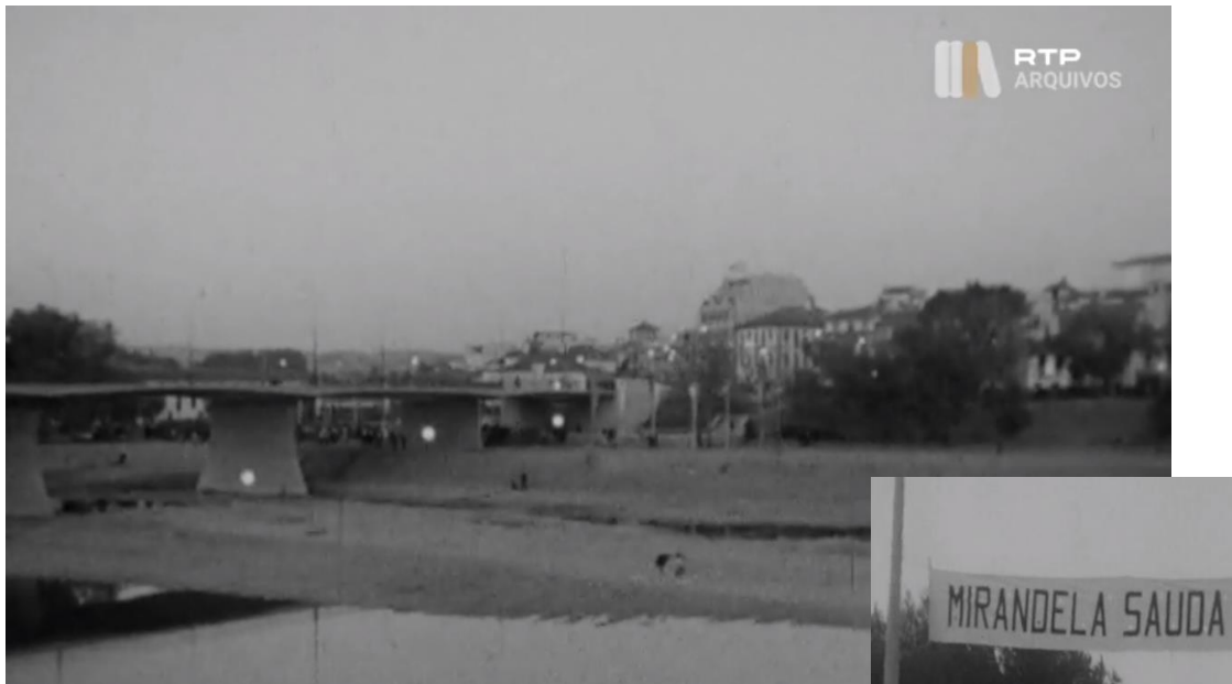
Figuras 25 e 26 - Ponte Eng.º José Machado Vaz (Ponte Nova) 1970, Arquivos RTP
