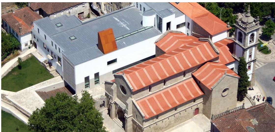
Figura 4 – Edifício do Conservatório Regional de Música de Vila Real (Foto tirada por Grupo Norvia)
