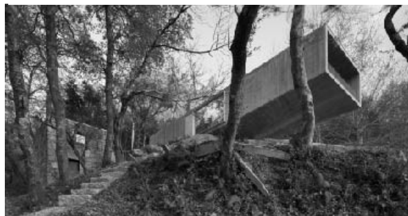
Figura 68 – Fotografia Casa no Gerês – Correia/Ragazzi
