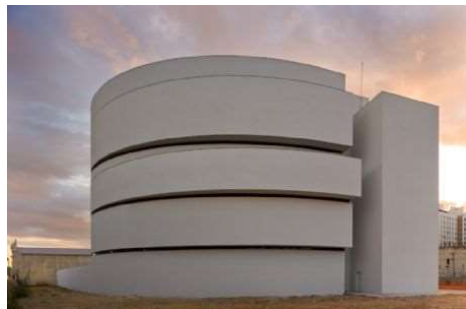
Figura 15 - Centro de Comandos Operacional de Lisboa de GLCS
