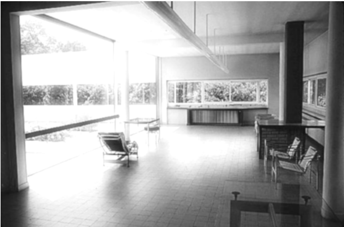
Fig. | 15 | Fotografía del interior de la Villa Savoye, vivienda proyectada por Le Corbusier donde se ven reflejados "Los 5 puntos de la Arquitectura": los pilotis , la planta libre, la fachada libre, la ventana corrida y la cubierta jardín; todos ellos en pos de un espacio residencial más higiénico.
