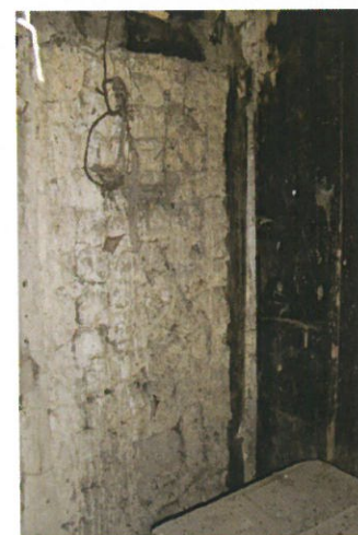
Fig.33 Parede em adobe (Inq.09).
