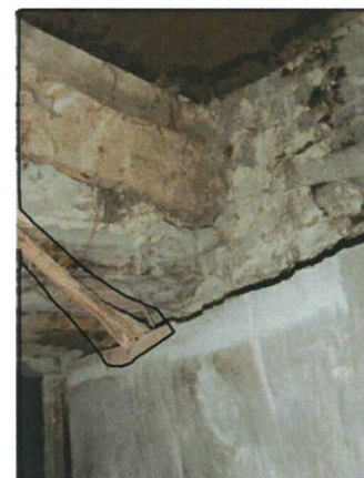
Fig.61 "Raposa" (peça de madeira que fixa a porta (Inq.02).
