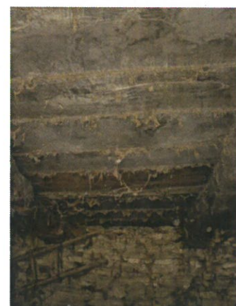
Fig.37 Sobrado visto do piso térreo (Inq.15)
