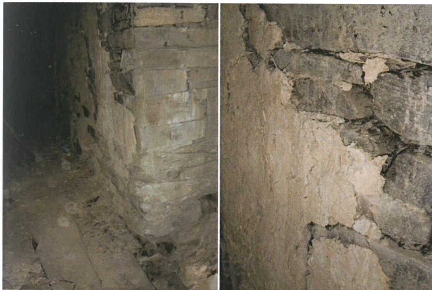
Fig.50 Rebocos interiores de barro (Inq.1).
