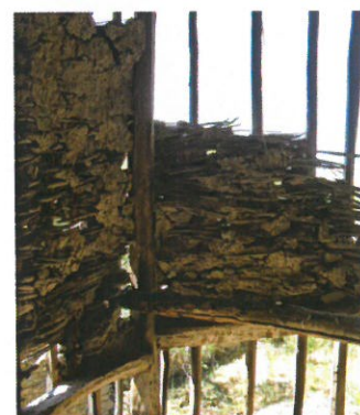
Fig.32 Tabique Exterior de vime com reboco (Inq.05)
