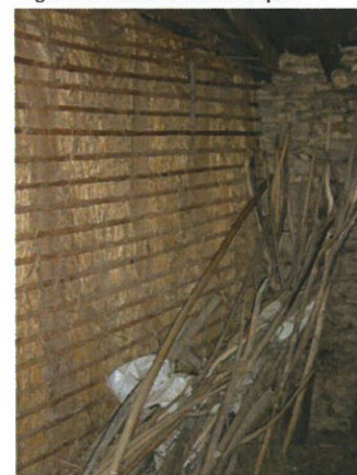
Fig.29 Tabique com enchimento a palha sem reboco (Inq.04).
