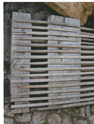
Fig.28 Estrutura de tabique.
