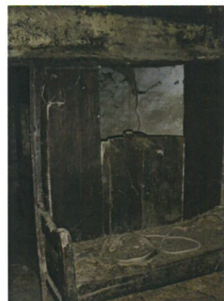
Fig.27 Divisória Interior composta por costas de escano e taipal de madeira (Inq.08).
