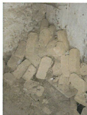
Blocos de Adobe
