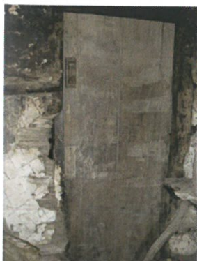
Divisória de tabique
