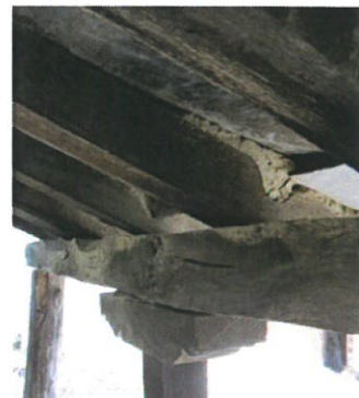
Fig.66 Pormenor de sapatas, frechal e barrotes na Varanda (Inq.05).
