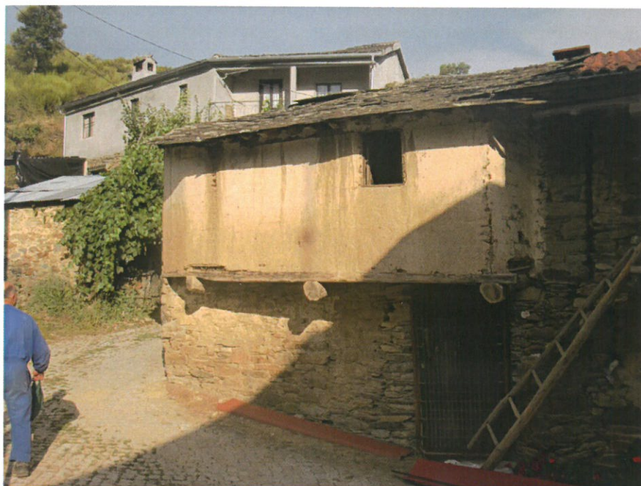
Fig.48 Reboco exterior de barro (Inq.7)
