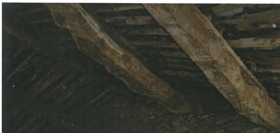
Fig.44 Estrutura Cobertura vista do interior (Inq.15).
