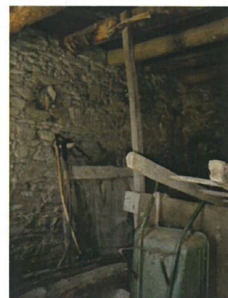
Fig.38 Sobrado visto do piso térreo (Inq.05).
