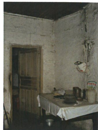
Fig.49 Reboco interior em barro.
