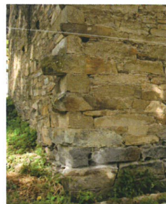
Fig.24 Cunhal com arranques para adição de nova unidade base (Inq.10).
