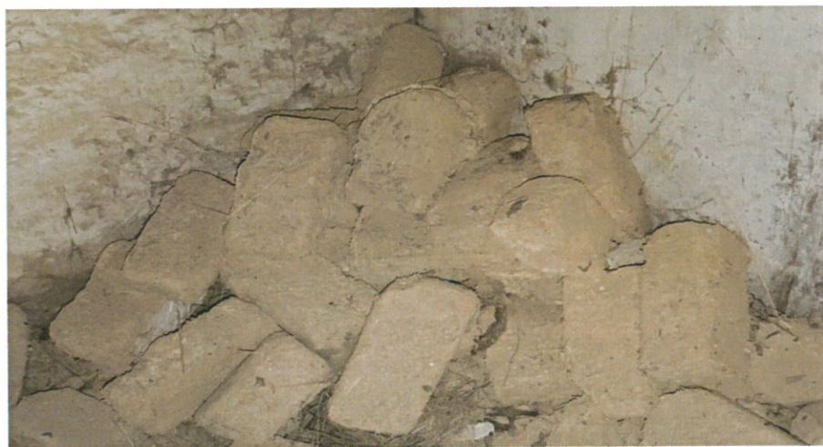
Fig.34 Blocos de adobe (Inq.08).
