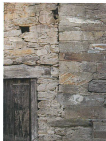
Fig.13 Contraste entre, tonalidades e qualidades de xisto dos aparelhos (Inq.01).
