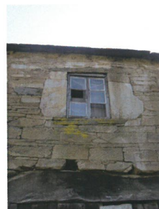
Fig.23 Alvenaria de xisto com aparelho acabamento fino. (Inq.08).
