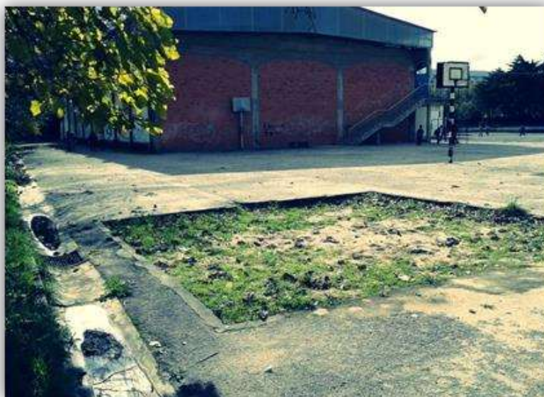
Figura 7. G3 Espaço Exterior Degrada
