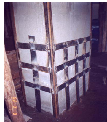
Figura 16: Reforço estrutural no pilar
