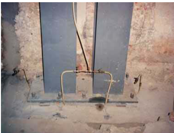
Figura 15: Reforço estrutural para transferência de carga
