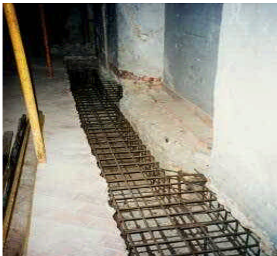
Figura 17: Reforço de pavimentos – viga de fundação
