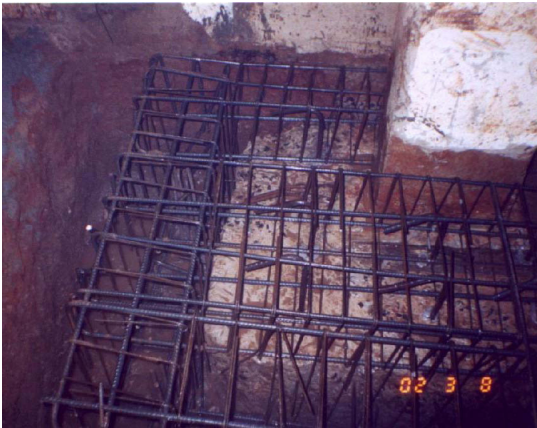
Figura 13: Reforço do maciço de encabeçamento das estacas
