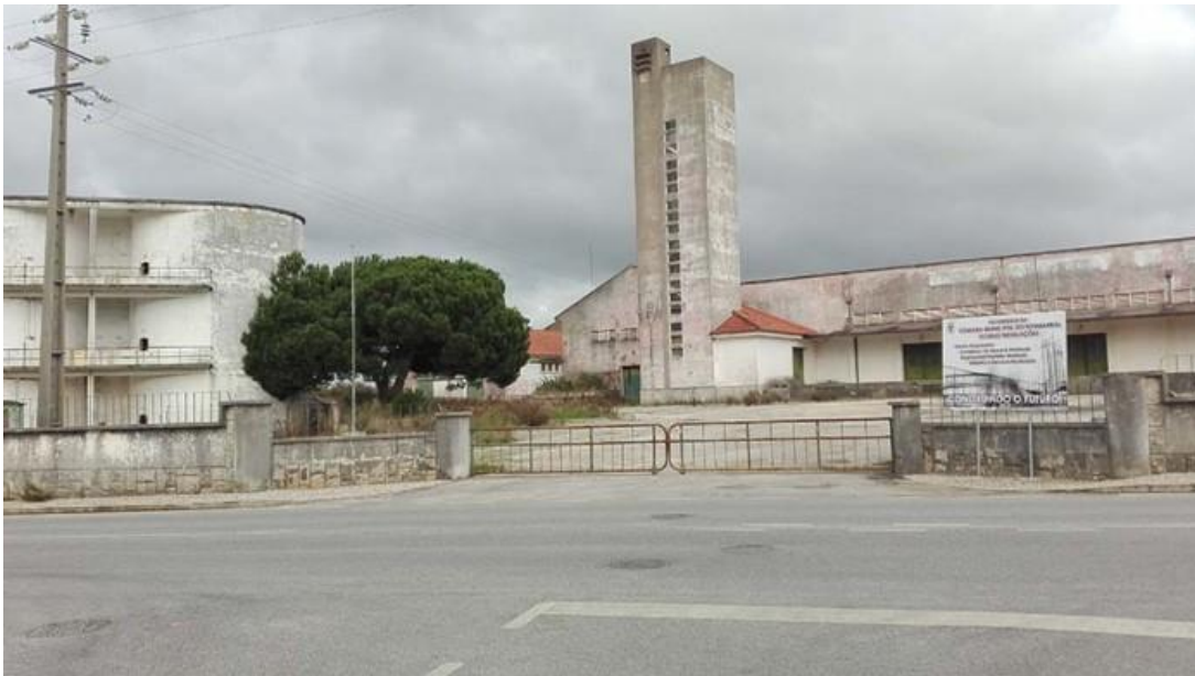
Figura 3 – Instalações para o Museu da Pera Rocha, no Bombarral.
