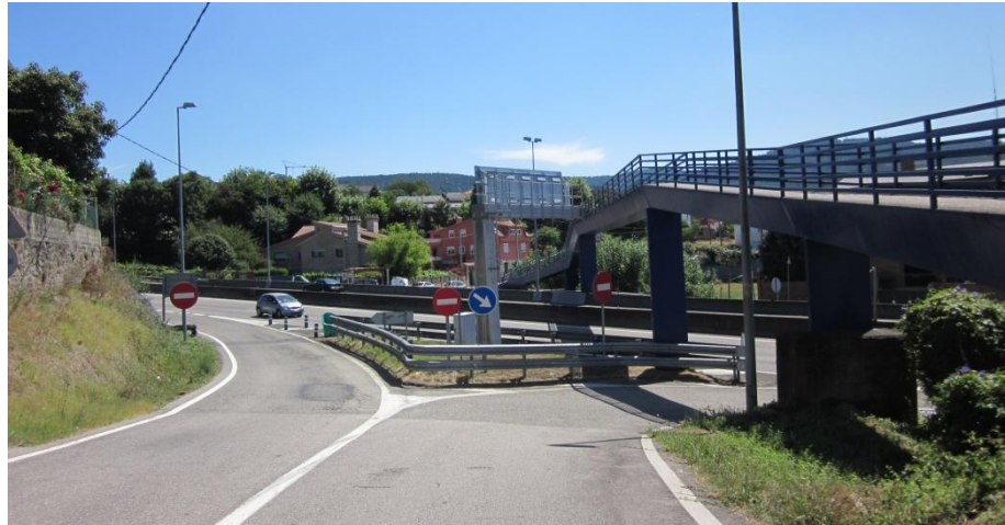
Fig. 4. 98: Imagen 3a , correspondiente a la conexión entre una vía secundaria y la autovía A-52, en la que se puede observar la barrera física que supone para el tránsito peatonal, siendo efectuado a través de una plataforma elevada.
