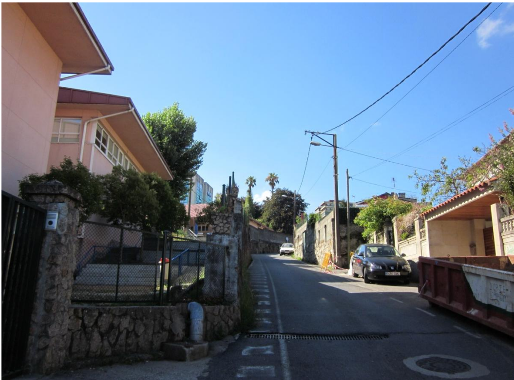
Fig. 4. 47: Imagen 3, vía secundaria del espacio interior, de ocupación residencial de baja densidad. La sección reducida de la vía junto con la aproximación de los cierres de las diversas parcelas a la misma condenan el desarrollo del espacio público, limitando el paso para los peatones a una pequeña franja lateral.
