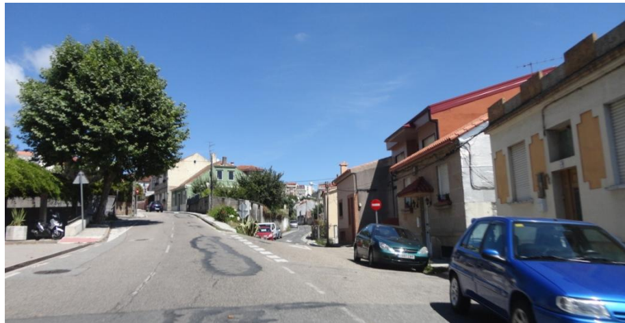
Fig. 4. 4. 84: Imagen 8, Ocupación de baja densidad sobre la red secundaria en las proximidades de las áreas de ocupación compacta. La conexión directa entre las edificaciones y la vía condiciona el espacio público, precario como se puede advertir, adquiriendo mayor protagonismo los flujos rodados.
