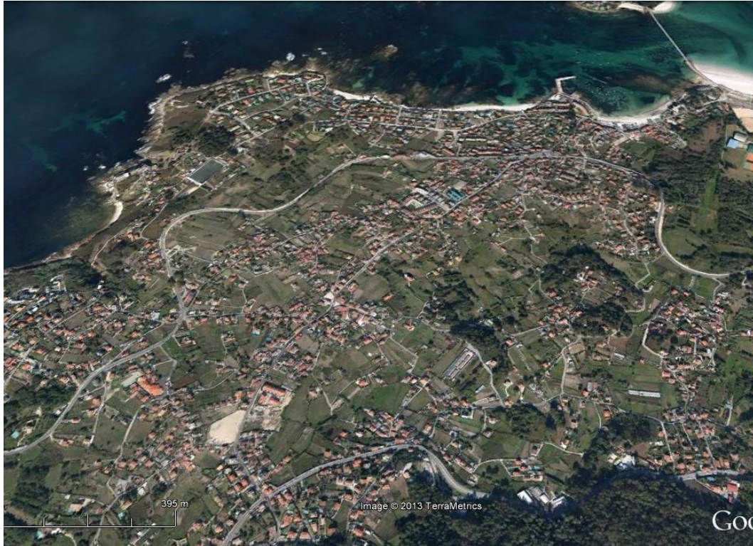
Fig. 4.4. 10: Vista general del lugar de Oia, en el litoral Oeste del área de estudio en el año 2010.
