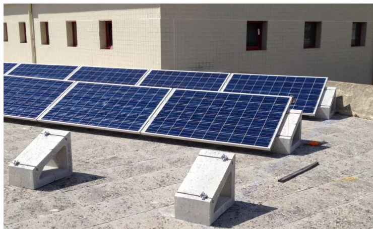
Figura 5.24 – Estrutura em betão para superfície plana ( Solarbloc ) [53]
