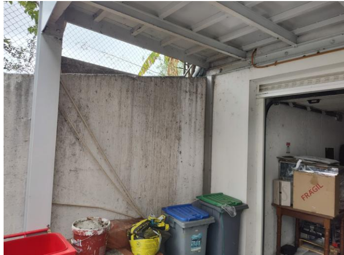
Figura 6.64 - Localização da zona técnica da instalação
