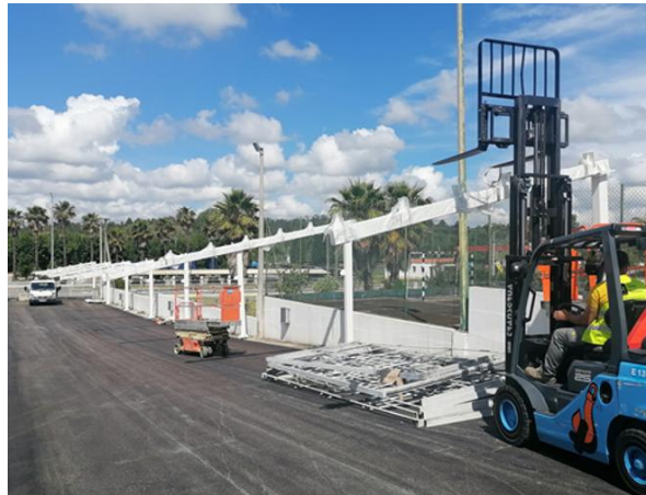
Figura 6.87 - Instalação da estrutura
