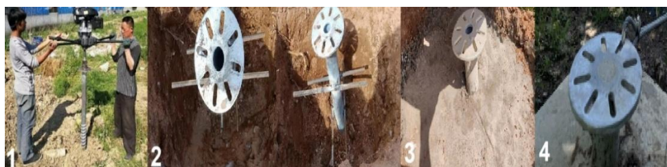
Figura 6.34 - Processo de ancoragem do sistema fotovoltaico flutuante [95]
