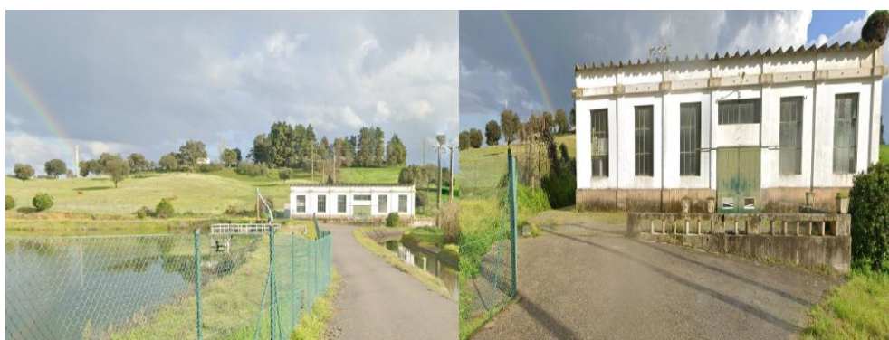
Figura 6.3 - Localização da zona técnica da instalação
