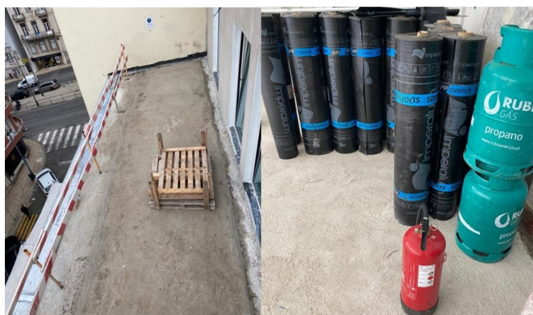
Figura 6 Preparação da varanda para ser impermeabilizada
