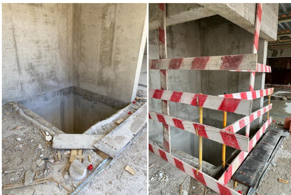
Figura 2 Registo fotográfico de situação de não conformidade/situação em conformidade
