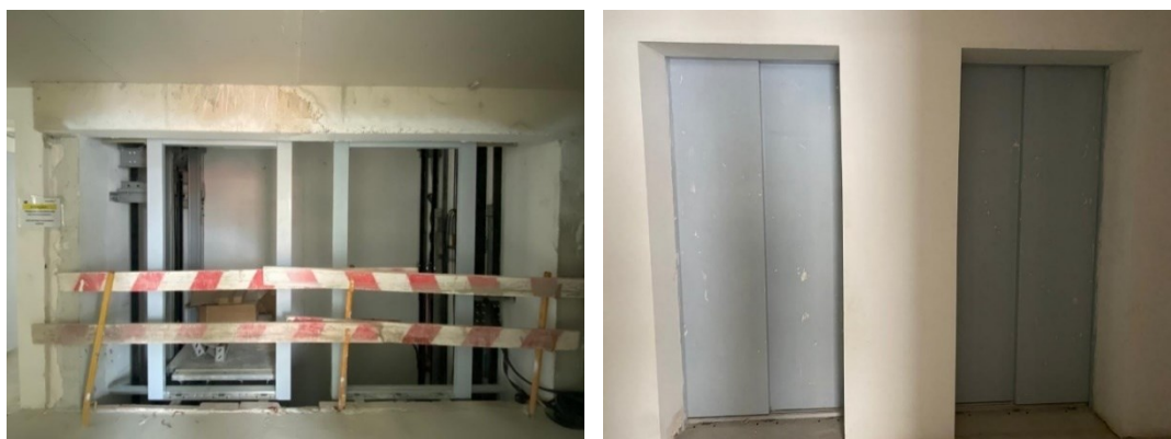
Figura 4 Imagens das "fases" da montagem dos elevadores
