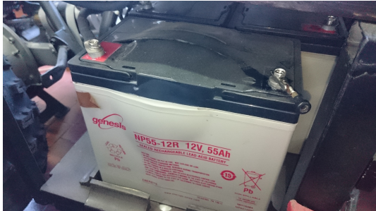
(g) Bateria danificada após carga fora da vida útil. Note-se que apesar de ter "inchado", a bateria não explodiu.
