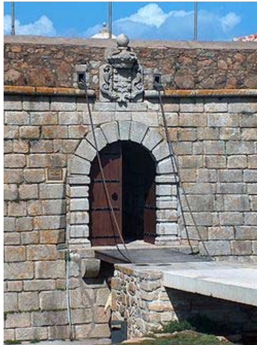
Figura 129. Portão de armas do Forte de São Francisco Xavier do Queijo.
