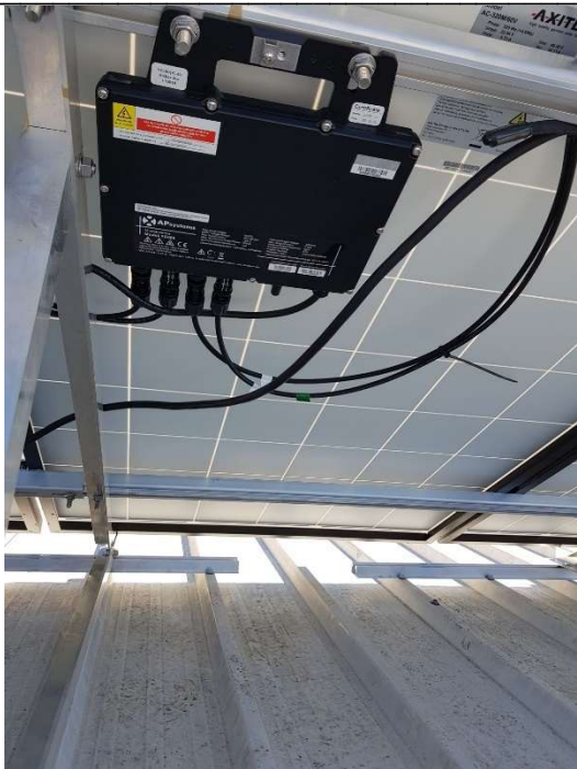
Figura 41 - Microinversor com as devidas ligações e localização
