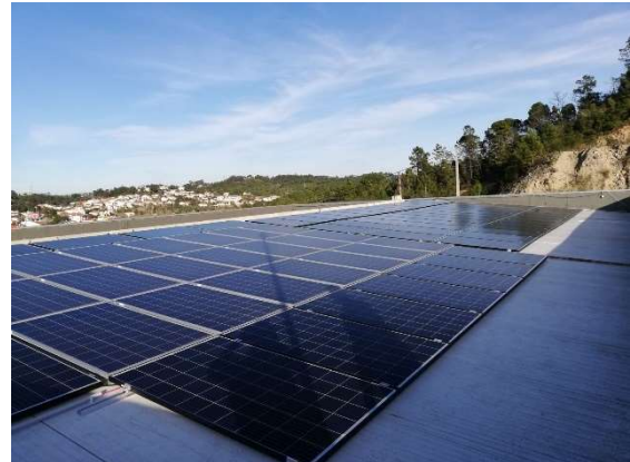
Figura 39 - Ampliação a FV existente (depois)
