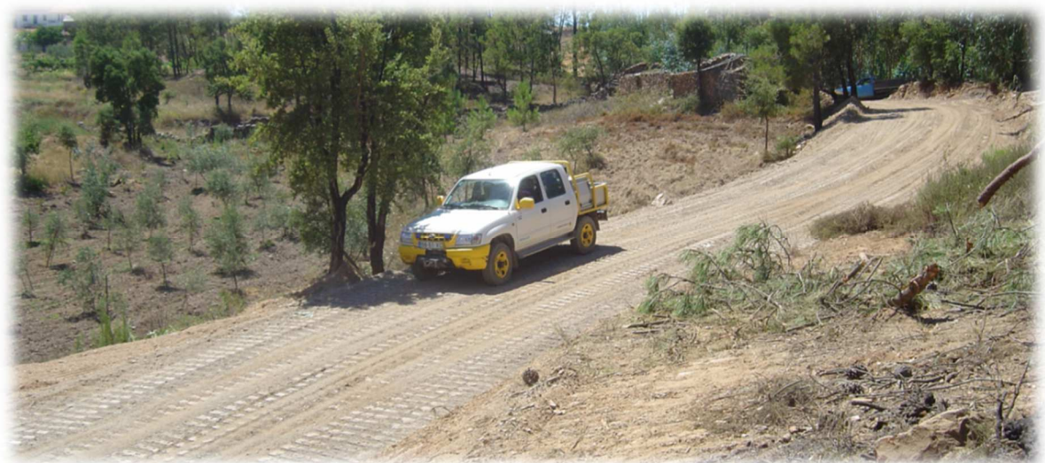
Figura 30 - Aspeto de Circular de Proteção depois de concluída
