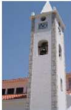
Torre da Igreja
