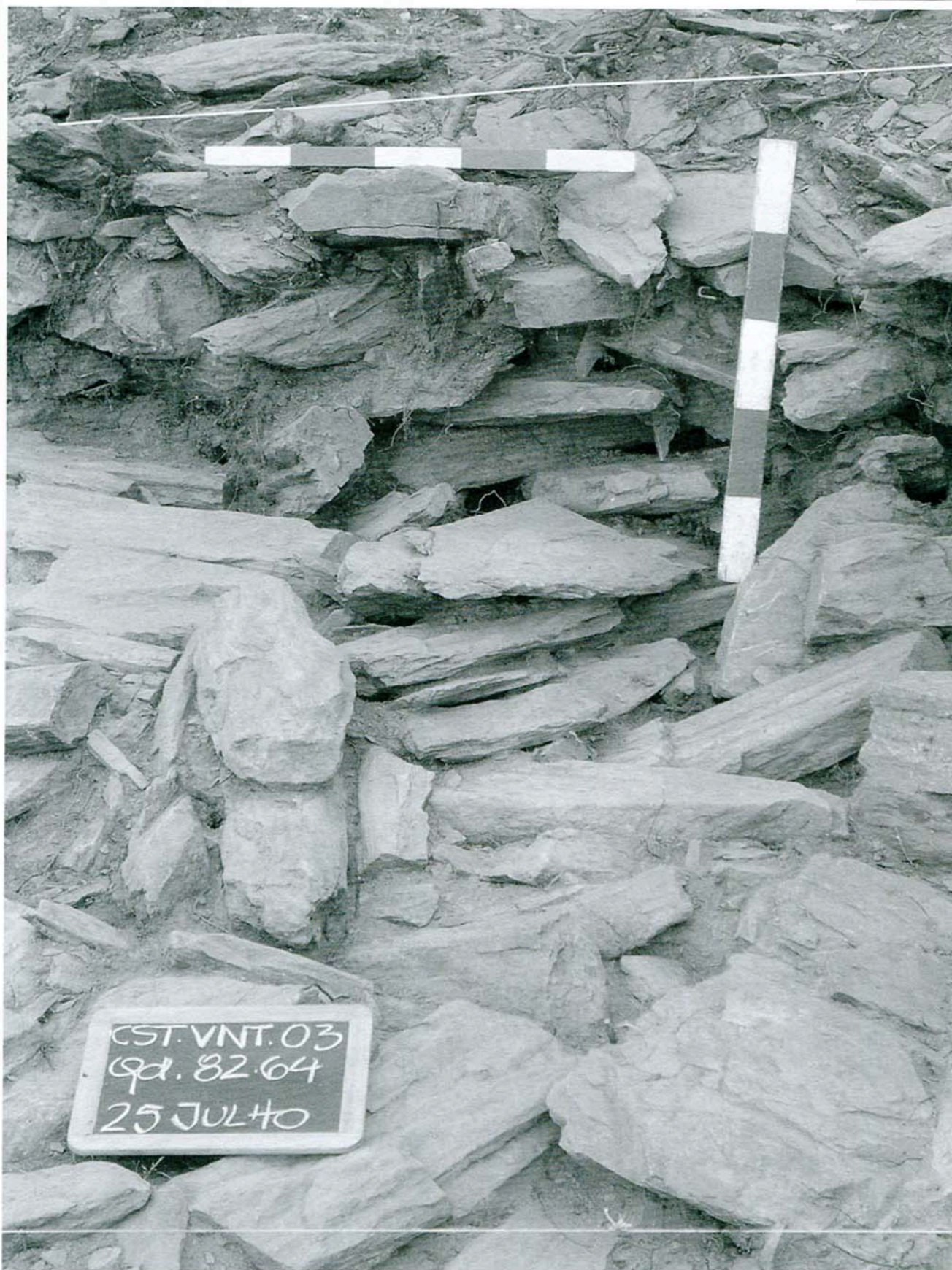
XXIII. Pormenor do enchimento interno da "Passagem" 5, visto de leste (do estradão)
