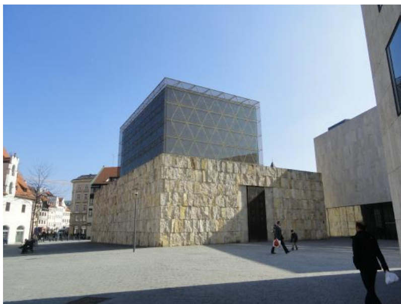
Imagem 26 - Perspetiva do exterior do edifício
