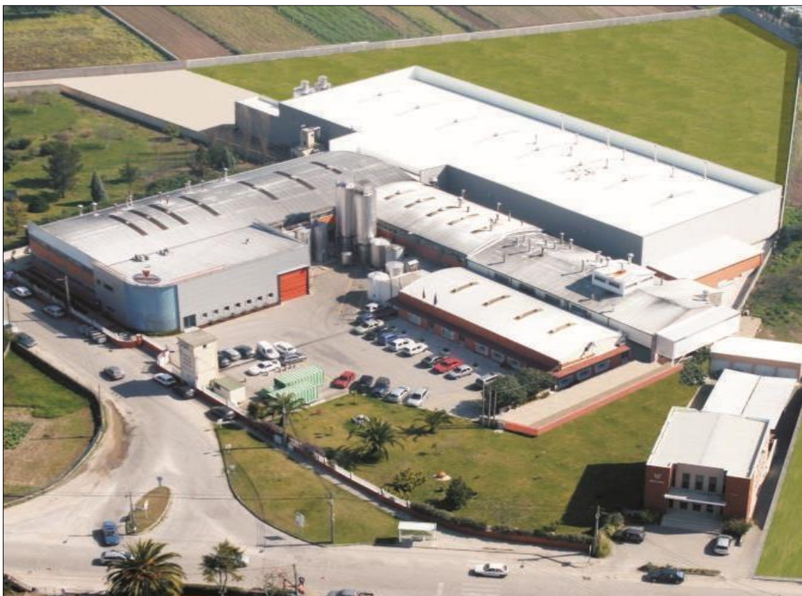
Figura 13: Imagem aérea da sede da Diatosta - Indústria Alimentar S.A., localizada em Oliveirinha, Aveiro-PT [59].
