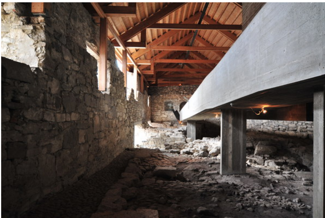
Fig.38 Museu Herdmark, aspecto da plataforma em betão sobrelevada
