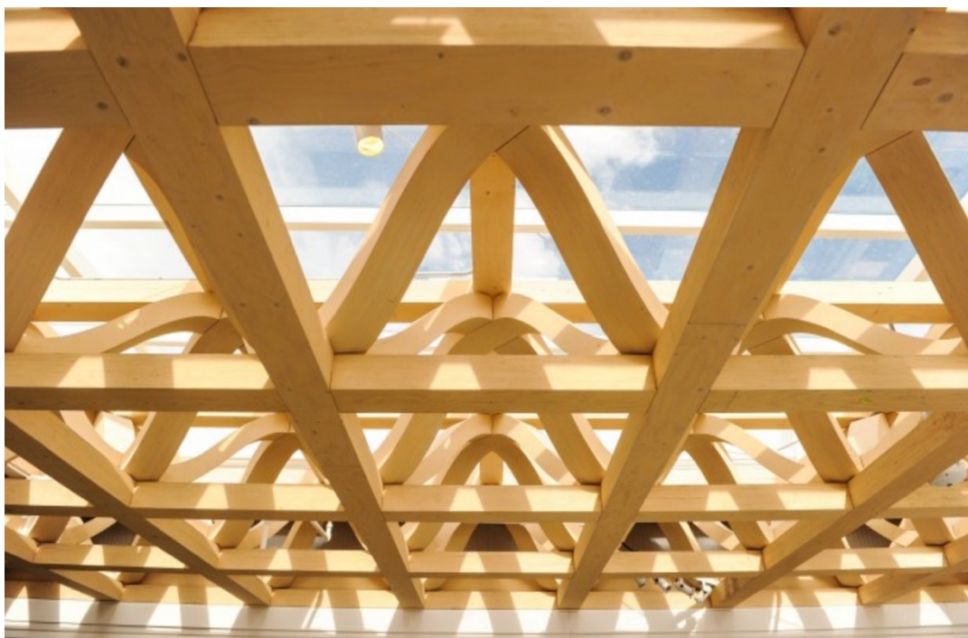
Fig.84 Museu de Arte de Aspen, detalhe da cobertura
