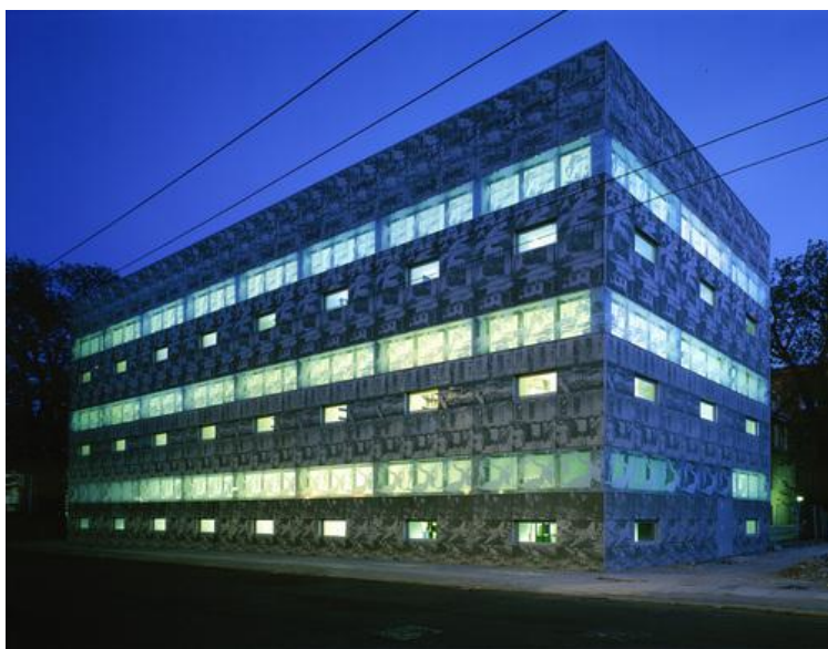
Fig.46 Biblioteca de Eberswalde, vista exterior
