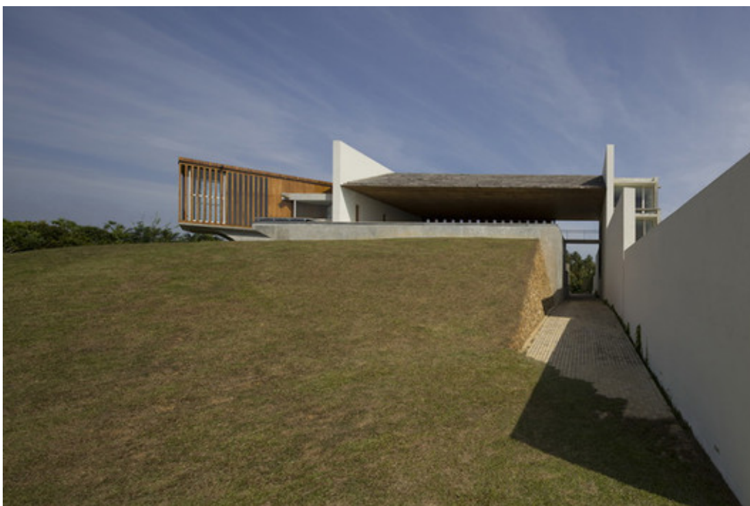
Fig.70 Villa Vista, percurso de acesso à habitação
