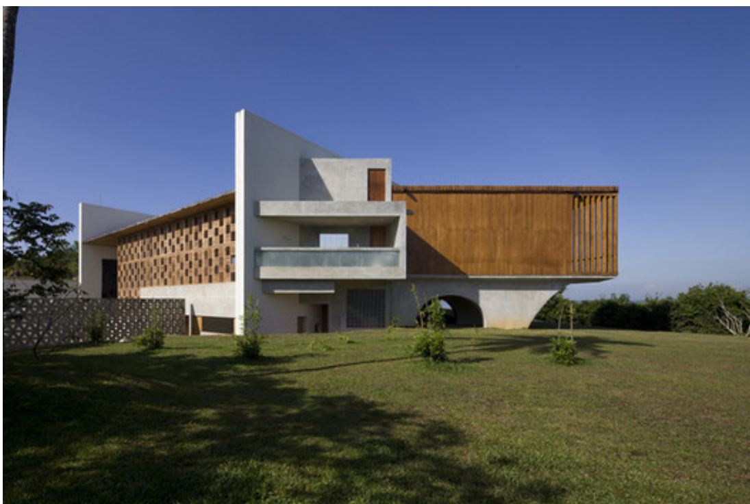
Fig.73 Villa Vista, vista para o módulo de madeira assente na estrutura em betão
