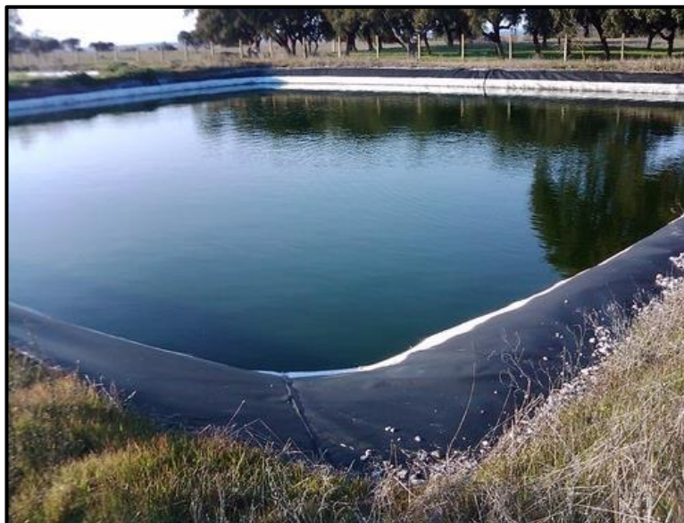
Figura 31 - Sistema de tratamento por Lagunagem (Machado, 2016)
