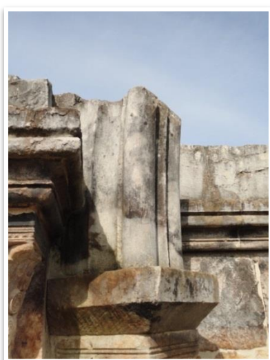
Figura A 125: Adulea do arranque dos arcos da abóbada do claustro da lavagem.
