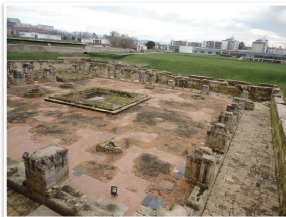
Figura A 92: Aspecto do claustro, inspeção periódica. 8-01-13
