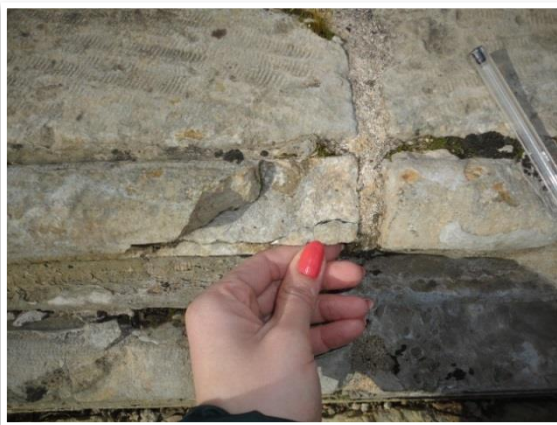
Figura A 97: Fragmento, estruturas do claustro, inspeção periódica. 6-02-13
