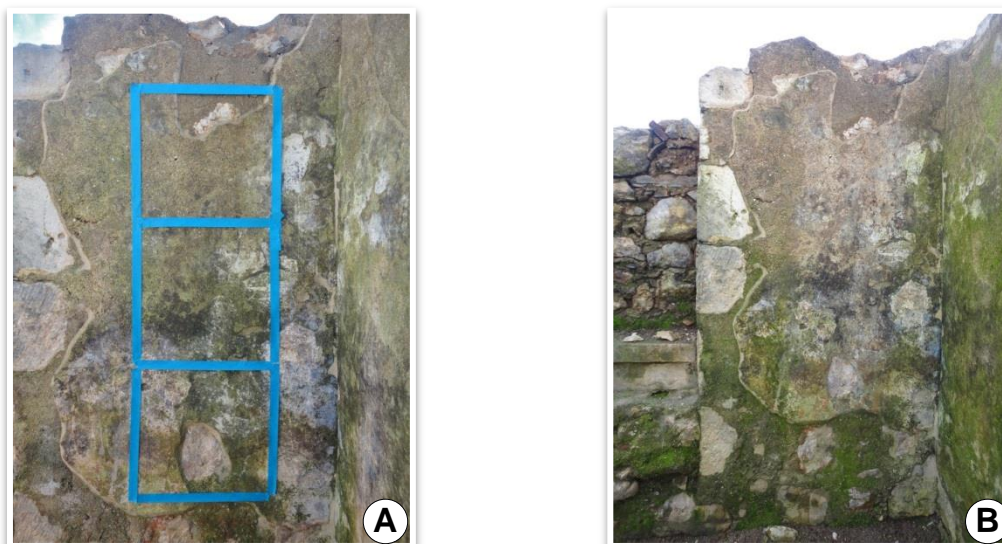
Figura 42: a) Antes e b) depois da aplicação de biocida, zona 3
