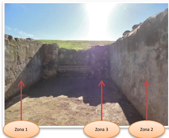
Figura 33: sala C, com zona 1, 2 e 3.
