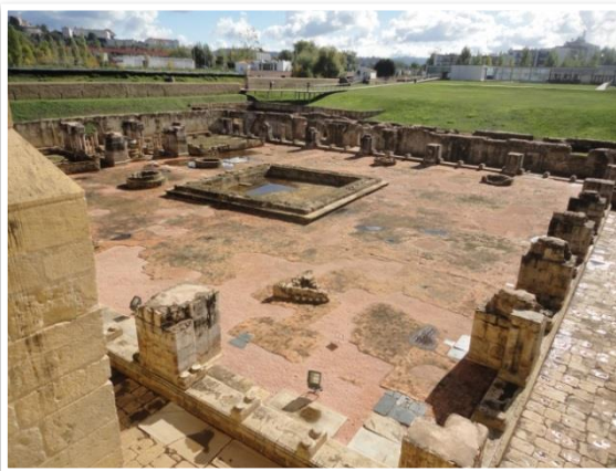
Figura A 83: Aspecto do claustro, inspeção periódica. 30-10-13
