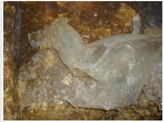
Figura A 23: Limpeza com agar-agar, remoção da película, brasão.
