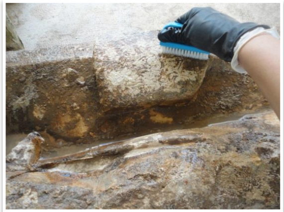
Figura A 11: Limpeza por lavagem, escovagem com escovas, brasão.
