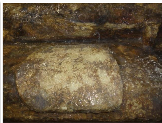
Figura A 20: Limpeza com agar-agar, película sobre a superfície em actuação, brasão.
