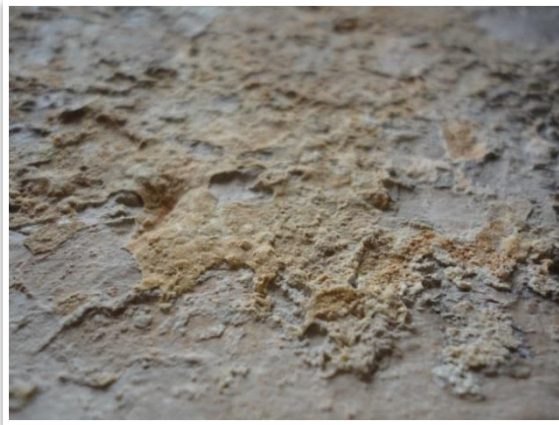
Figura A 10: Concreções calcárias sobre a superfície, brasão.
