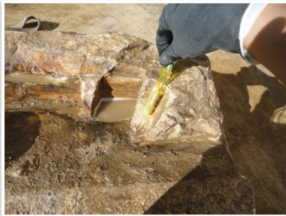
Figura A 12: Limpeza por lavagem, escovagem com escovas, brasão.
