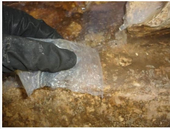
Figura A 22: Limpeza com agar-agar, remoção da película, brasão.
