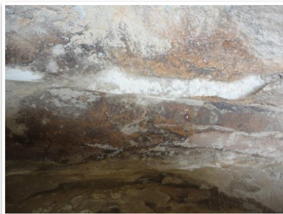
Figura A 8: Marcas ferrosas originadas pela água, brasão.
