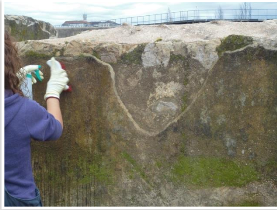
Figura 38: Lavagem e remoção de biocida, zona 1
