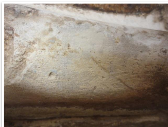
Figura A 31: Superfície limpa evidenciando pitting , anteriormente não detectado, brasão.
