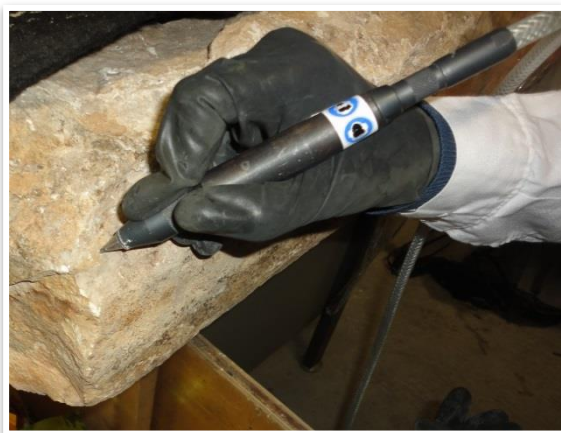
Figura A 16: Desbaste com micro-martelo-pneumático, brasão.
