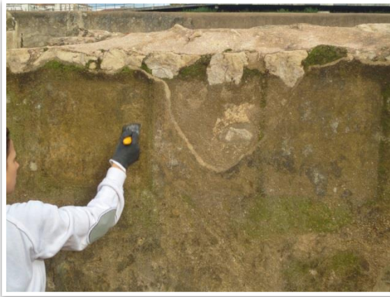
Figura 36: Ciclo 3, aplicação de biocida, zona 1
