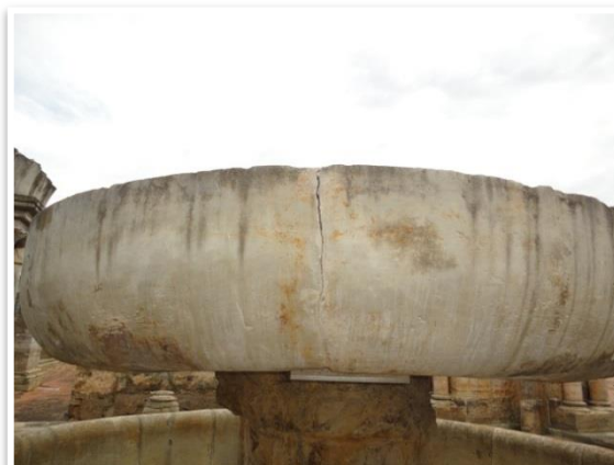
Figura A 79: Fractura da pia, claustro da lavagem, Claustro, inspeção periódica. 23-10-13-13
