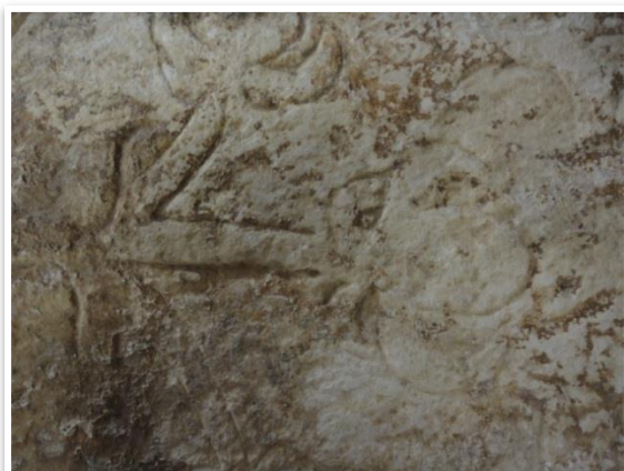
Figura A 28: Superfície do escudo após a limpeza com agar-agar, brasão (pormenor, escudo).
