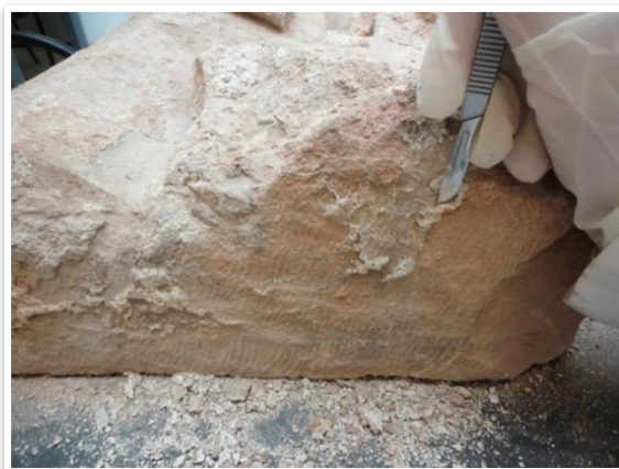
Figura A 4: Argamassas sobre as laterais da pedra do brasão.
