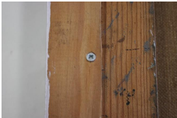
Figura 97 – Parafuso colocado para fixar a moldura à grade da pintura.
