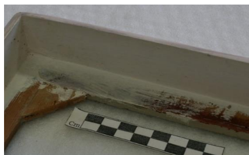
Figura 48 – Pintura descuidada da moldura.
