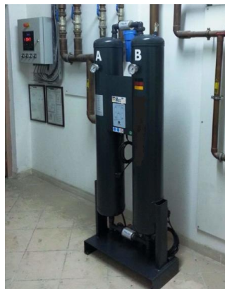
Figura 2.12 – Secador de Absorção [32]
