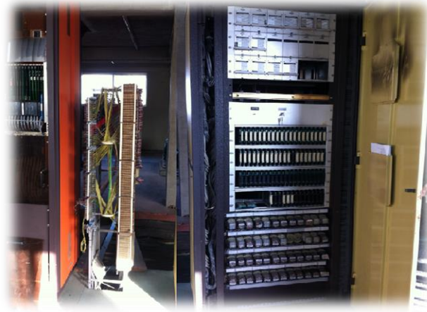
Figura 3.13- Visita à antiga Subestação de Seia
