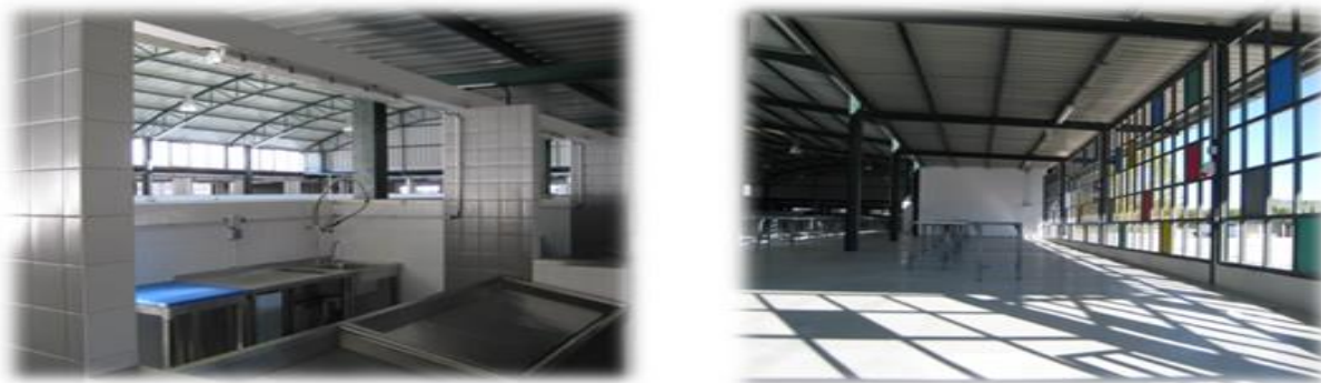
Figura 32: Mercado Coberto Reabilitado, setembro 2009 (Arquivo fotográfico do autor)
