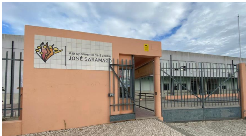
Figura 1 - Entrada da escola sede AEJS
