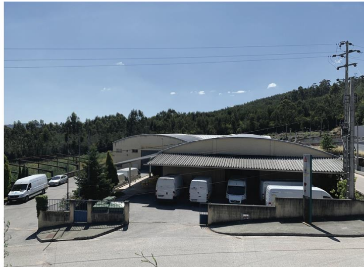
Figura 7: Instalações da fábrica
