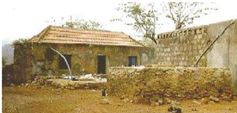
Figura 22: Captação da água da chuva através do telhado – CV Fonte: PEREIRA, L. S. (2009)
