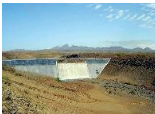
Figura 14: Barragem de Salineiro ainda em construção Fonte: MDR
