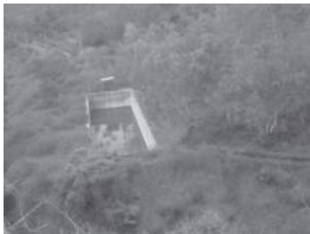
Figura 20: Reservatório de água Fonte: ferreira et al. (2013)
