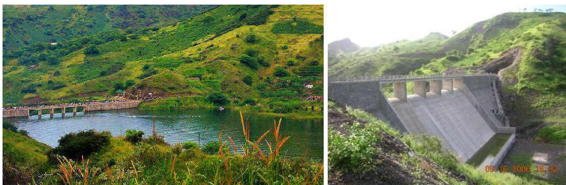
Figura 13: Barragem de Poilão Fonte: MDR
