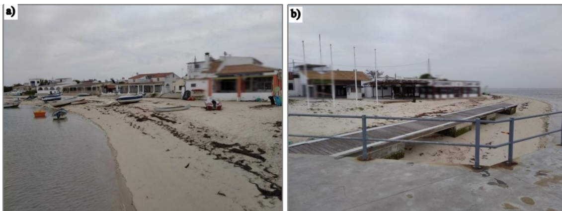
Figura 14: Exemplos do edificado existente no lado Norte da Ilha de Armona. a) Lado Oeste do cais de embarque. b) Lado Este do cais de embarque. Fonte: Fotografias tiradas por Maria Helena (2021).
