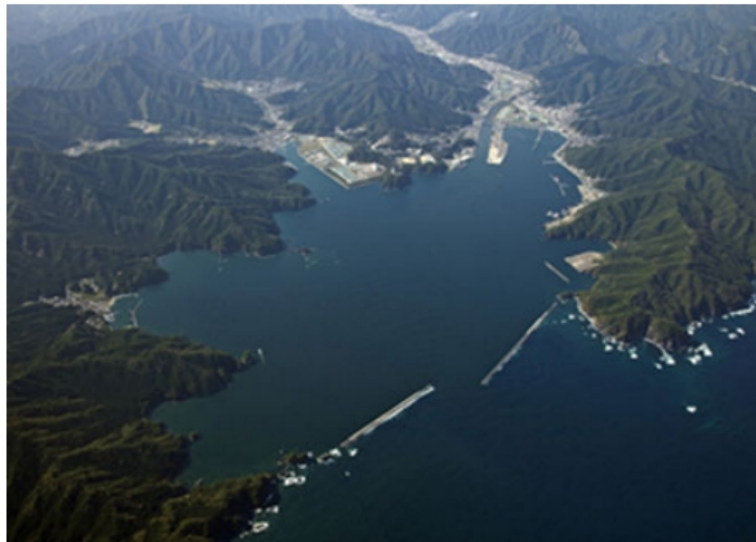
Figura 55: Quebra mar de Kamaishi (japão), antes do tsunami de 2011. Fonte: Suppasri et al. (2013).
