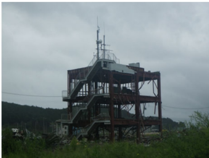
Figura 44: Edifício destinado à evacuação da população para cotas superiores em caso de tsunami na cidade de Minami-Sanriku, em 3 de setembro de 2011 (Japão). Fonte: Suppasri et al. (2013).
