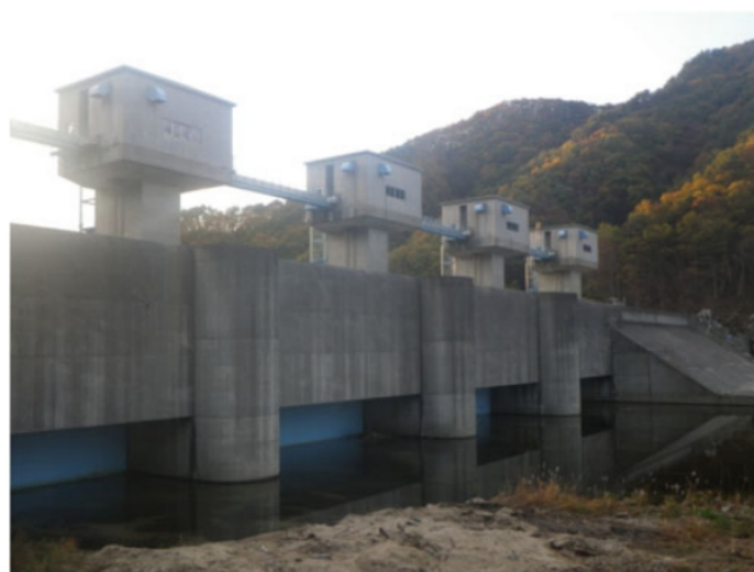
Figura 43: Comportas hidráulicas que protegeram a cidade de Fudai (Japão) do impacto do tsunami de 2011. Fonte: Suppasri et al. (2013).
