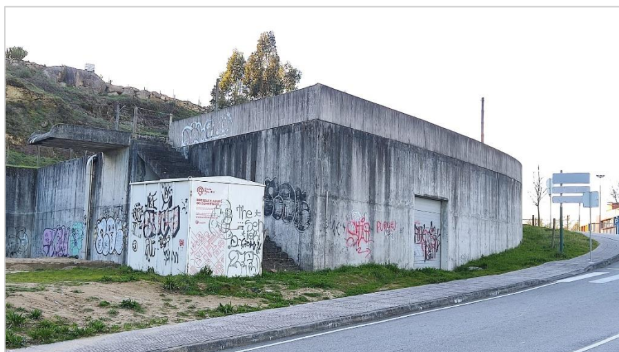
Figura 14 - Edifício Proposto para o Centro Municipal de Proteção Civil Fonte: Fotografia do Autor (2024)
