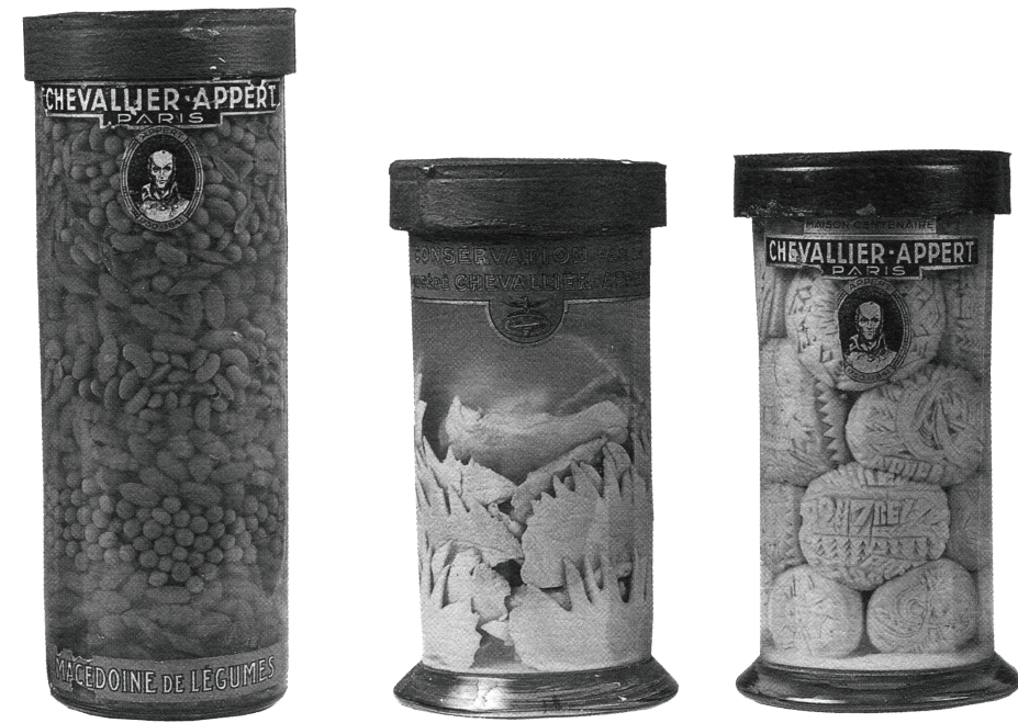
07 Embalagens de Appert, fabricadas em 1892. Os legumes são alojados em frascos de vidro espesso fechados por uma rolha de cortiça, forrada por uma cápsula metálica.
