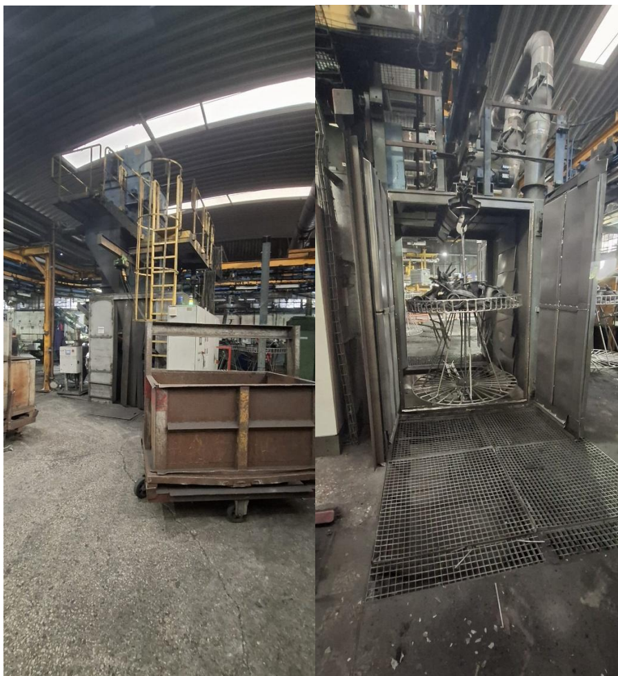
Figura 4.35 - Máquina da granalha
