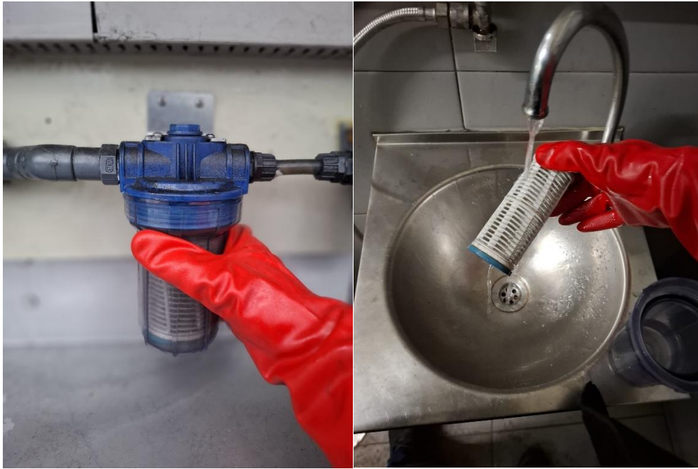
Figura 4.29 a) Desmontar copo do filtro b) Lavagem do filtro
