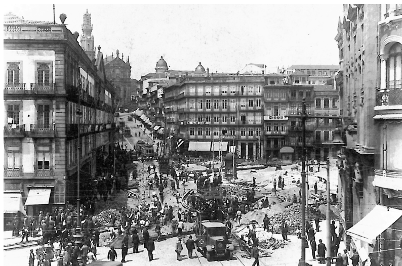
FIG. 13 Obras de ampliação da rede na Praça da Liberdade em finais do século XIX.
