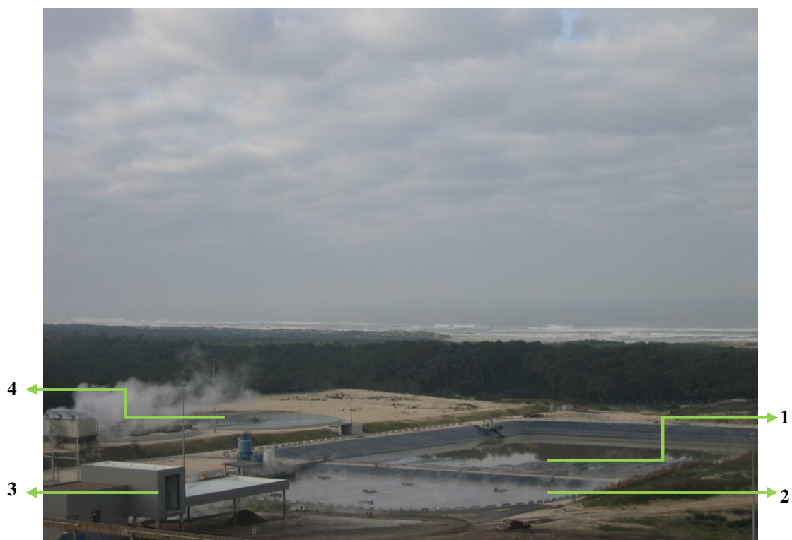
Figura 4.7 – Vista geral da estação de tratamento secundário (EP, 2012): 1- Bacia de emergência; 2- Bacia de equalização; 3- Desidratação de lama; 4- Reator MBP e clarificador secundário.
