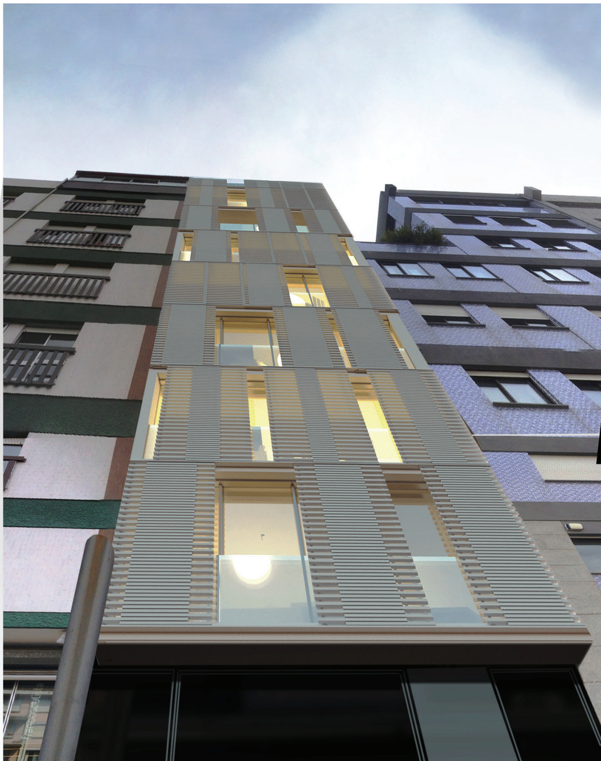
Figura 84. Vista perspética do prédio em reconstrução.
