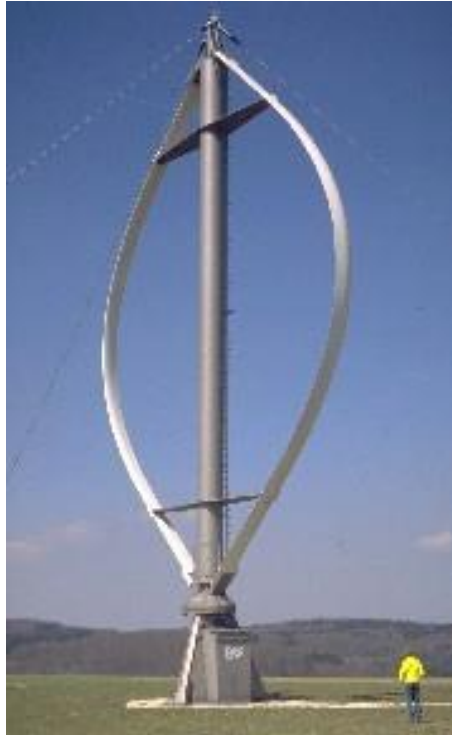
Figura 7-Turbina de sustentação tipo “Darrieus” (pás de forma troposkiana) (extraído de [2])
