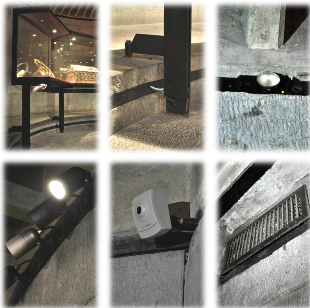
Figura 4.25 - Infraestruturas técnicas nos rodapés e rodapés do museu do Tesouro de S. Lorenzo.
