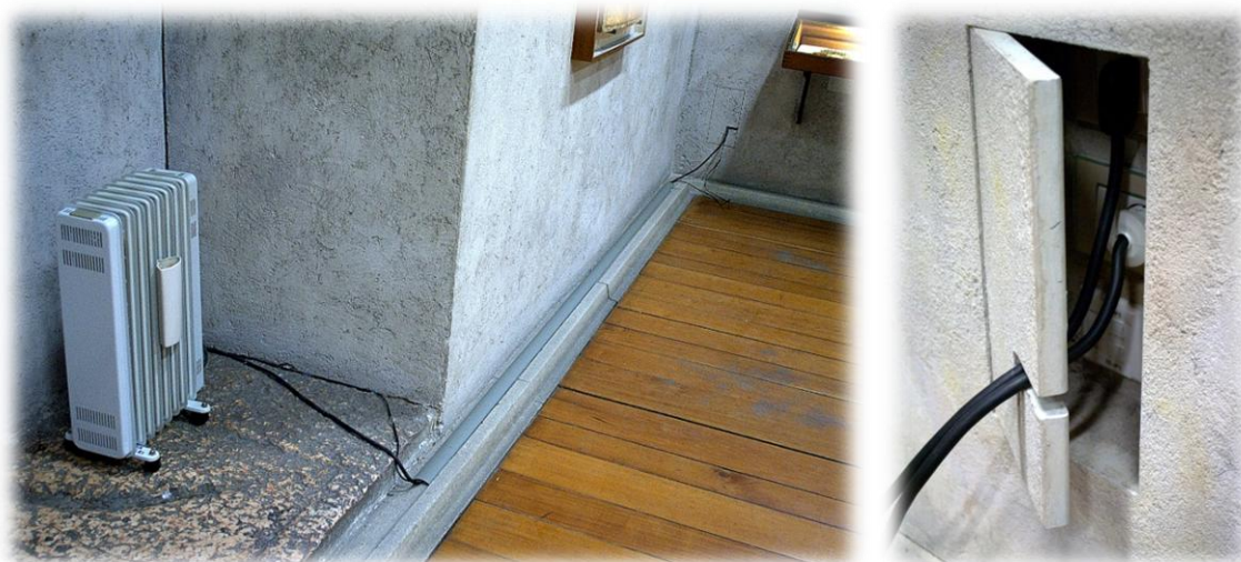
Figura 4.9 - Utilização de aquecedores a óleo (esquerda) e exemplo das caixas técnicas (direita) no Castelvecchio.
