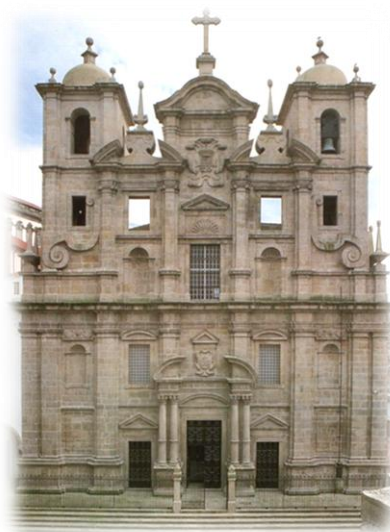
Figura 5.6 - Fachada da Igreja de São Lourenço, Porto.
