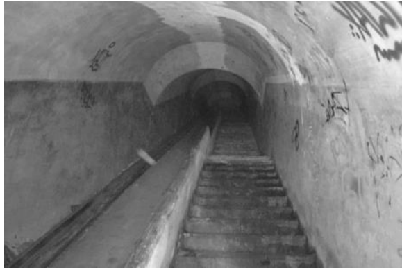
99. Interior escaleras inferiores túneles
