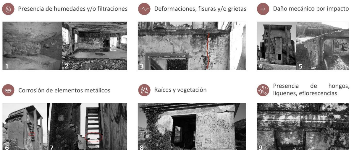
102. Ficha 01 Estado de conservación y patologías
