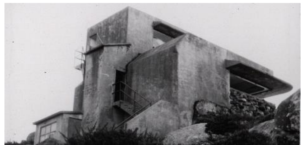
93. Sala de telemetría
