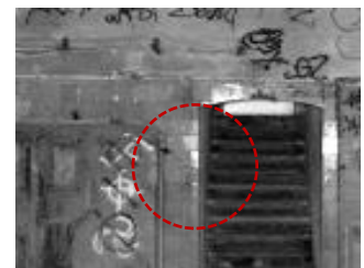
114. Vista fondo escaleras
