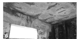
103. Ficha 02 Estado de conservación y patologías
