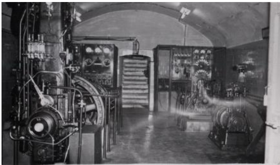
90. Sala de máquinas, baterías y cuadros de distribución
