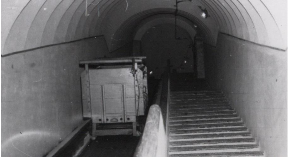
89. Descenso de vagoneta con munición en la Batería J4
