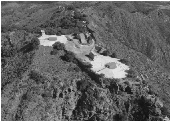
13. Vista aérea Batería de Cenizas C-9
