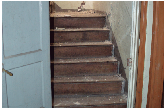
Fig. 116: Escaleras de madera del Caso 6
