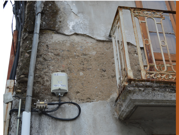
Fig. 93: Detalle tapia en fachada - 19.08.2014
