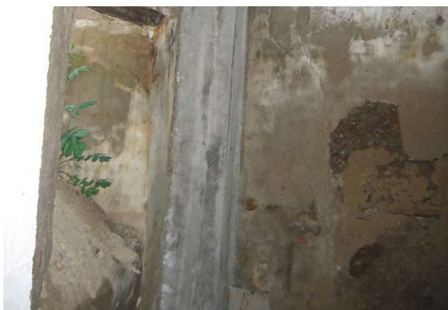
Fig. 546: Detalle tabiquería interior - 24.04.2009
