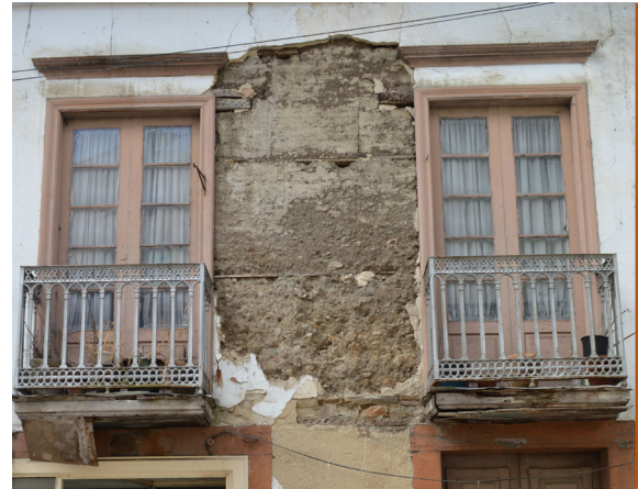
Fig. 69: Detalle tapia en fachada - 19.08.2014
