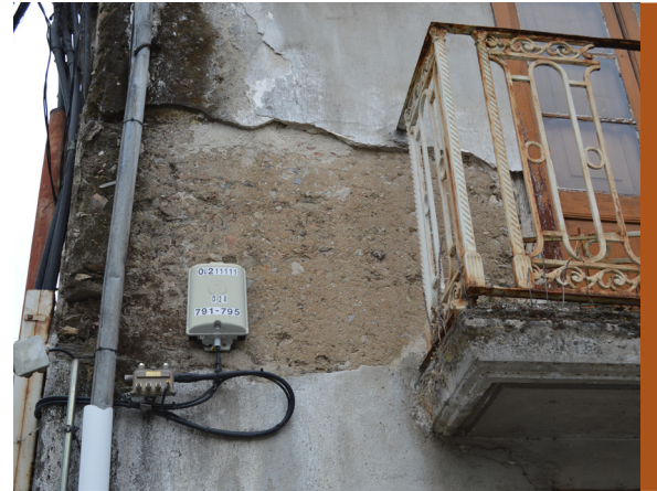
Fig. 559: Detalle tapia en fachada - 19.08.2014
