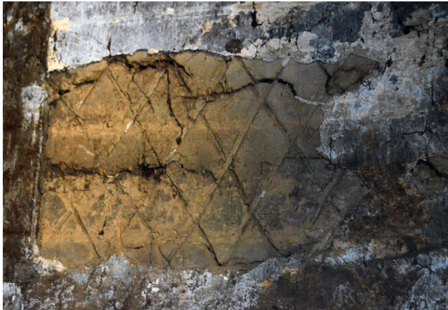
Fig. 92: Detalle tabiquería interior - 26.08.2014
