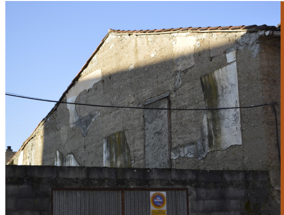
Fig. 53: Tapia fachada norte - 08.02.2015
