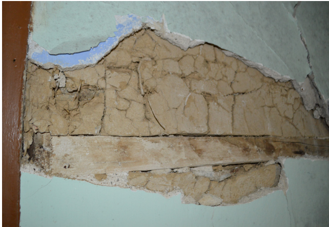
Fig. 76: Detalle tabiquería interior - 20.08.2014
