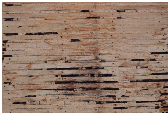
Fig. 125: Barrotillo de una pared interior del Caso 8
