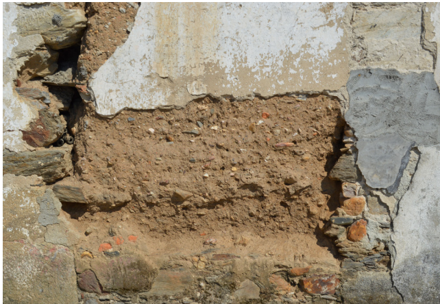
Fig. 44: Detalle tapia en fachada - 18.08.2014
