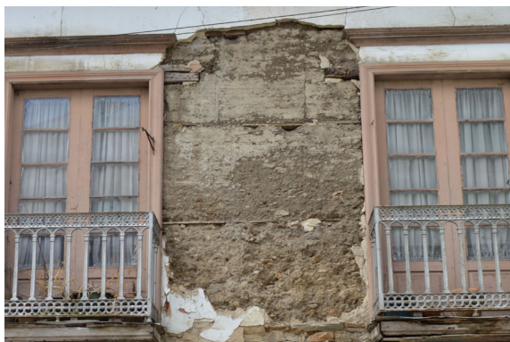
Fig. 128: Tapia con elementos horizontales de madera del Caso 6 - Año de construcción: 1880
