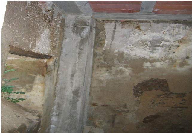
Fig. 52: Detalle tabiquería interior - 24.04.2009
