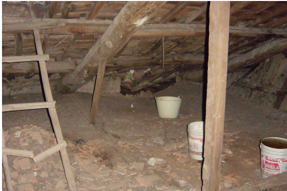
Fig. 115: Armazón de la cubierta del Caso 1
