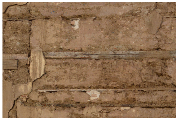
Fig. 127: Tapia con elementos horizontales de madera del Caso 1 - Año de construcción: anterior a 1900
