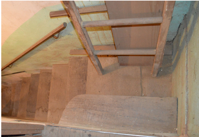
Fig. 60: Detalle escalera interior - 21.08.2014
