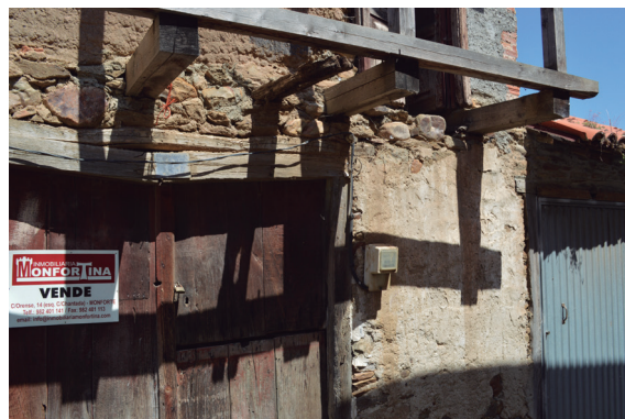
Fig. 110: Granito en la planta baja del Caso 8
