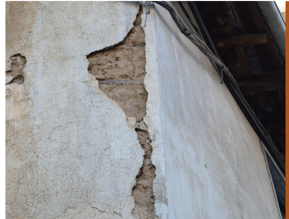
Fig. 551: Detalle tapia en fachada - 18.08.2014
