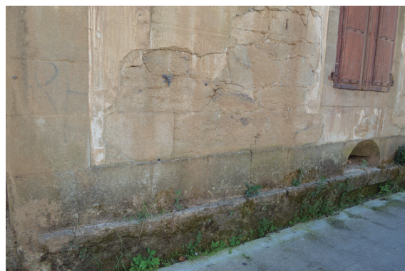
Fig. 121: Mampostería del muro exterior del Caso 1
