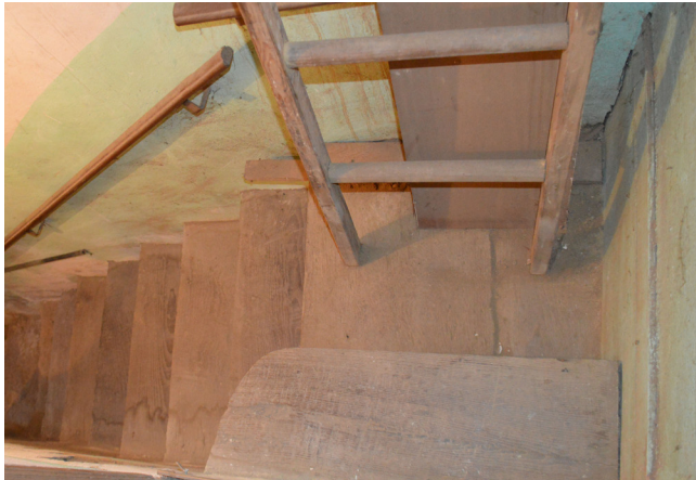
Fig. 550: Detalle escalera interior - 21.08.2014
