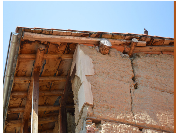
Fig. 85: Detalle tapia en fachada - 19.08.2014
