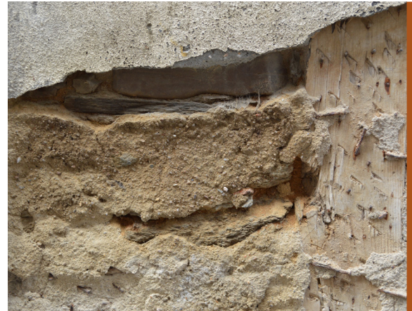
Fig. 77: Detalle en fachada - 19.08.2014
