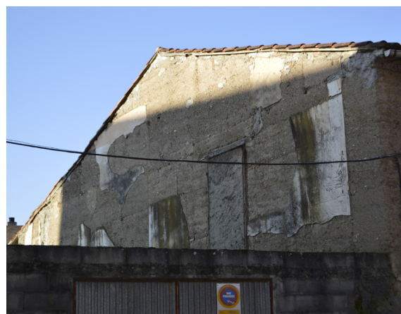
Fig. 547: Tapia fachada norte - 08.02.2015
