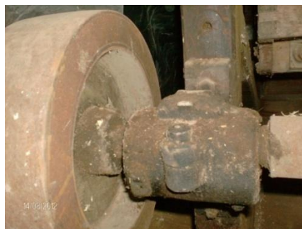
Figura 44 – Poeiras, óleos de lubrificação, elementos metálicos oxidados; Foto Rita Rosa, 14.Ago.2012;
