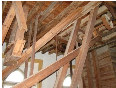
Figura 16 – Nora e calhas (madeira); Foto DOM – CMT, 7.Fev.2011;
