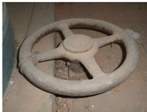
Figura 18 – Fotografia do aliviadouro, roda em ferro; Foto Rita Rosa, 3.Jul.2012;
