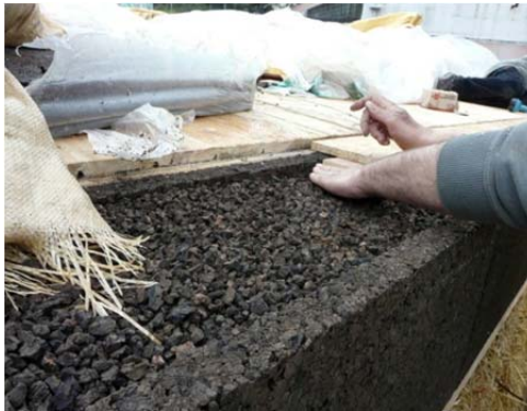
Fig. 273: Aislamiento de corcho en arista de tejado
