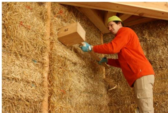
Fig. 274: Detalle interior balas de paja
