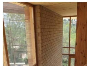
Fig. 37 - Muro de ladrillo adobe
