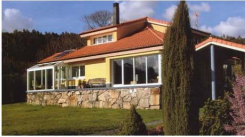
Fig. 195y 196: Fachada sur antes última reforma
