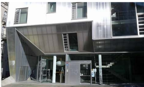
Fig. 267: Detalle zona de acceso
