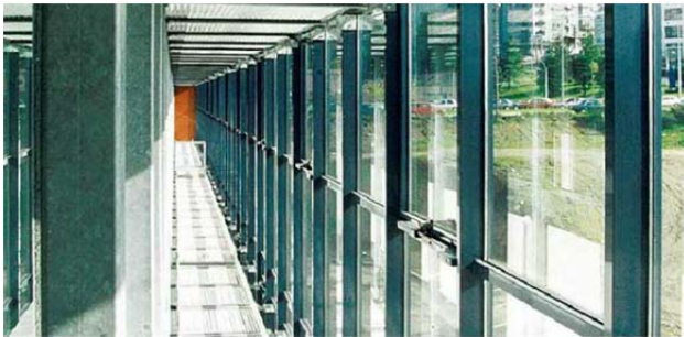
Fig. 347: Detalle interior de la galería
