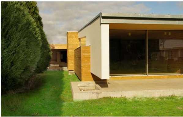
Fig. 301: Fachada captación solar
