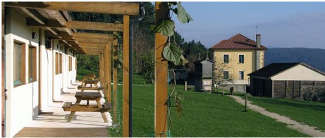
Fig. 215: Pérgola en fachada sur
