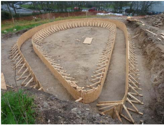
Fig. 286: Detalle encofrado de la cimentación
