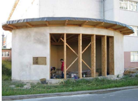
Fig. 272: detalle acabado cal exterior
