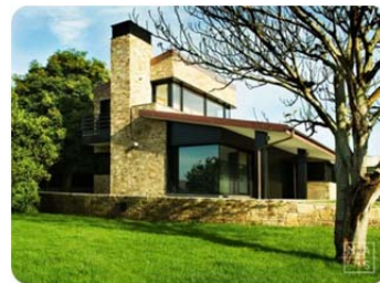
Fig. 51- Protección vegetal en una vivienda
