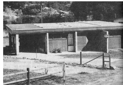
Fig. 20- Cubierta de agua con paneles aislantes
