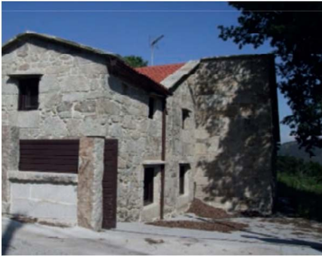
Fig. 100: Vivienda unifamiliar en Pontecaldelas
