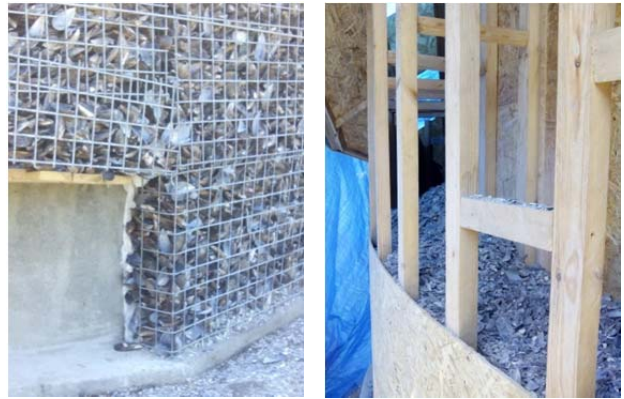
Fig. 287: Detalle gaviones rellenos de conchas
