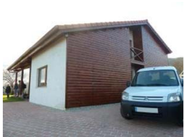
Fig. 246: Fachada noroeste en madera
