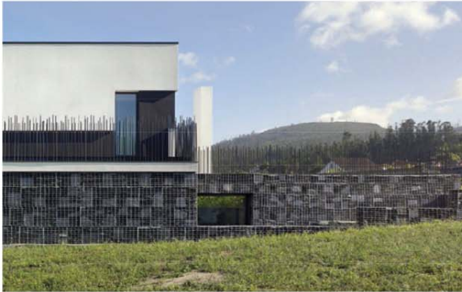
Fig. 319: Fachada sur con muros de gaviones
