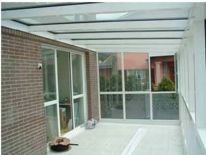
Fig. 206: Vista interior del invernadero
