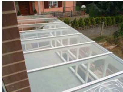
Fig. 207: Vista superior del invernadero
