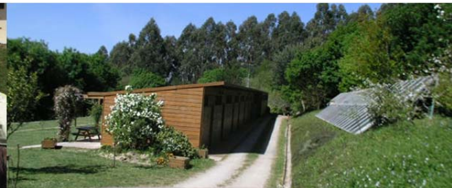
Fig. 218: Parte posterior – fachada norte
