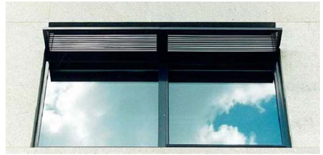
Fig. 348: Detalle del alero
