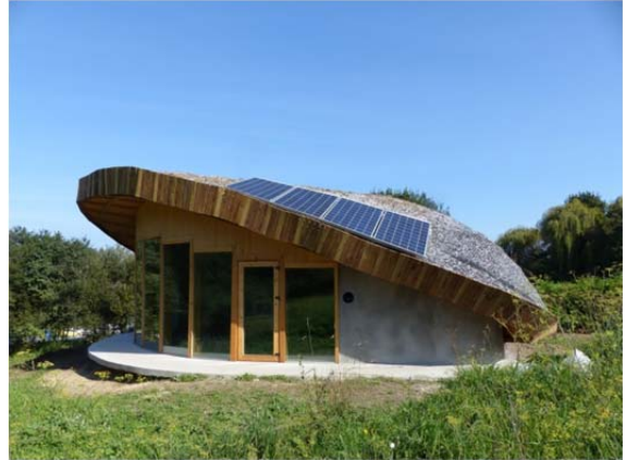
Fig. 285: Fachada este del edificio
