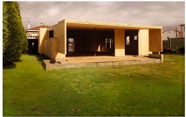
Fig. 302: Estructura de madera (durante la obra)
