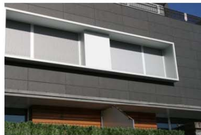
Fig. 7- Ventanales, captación directa
