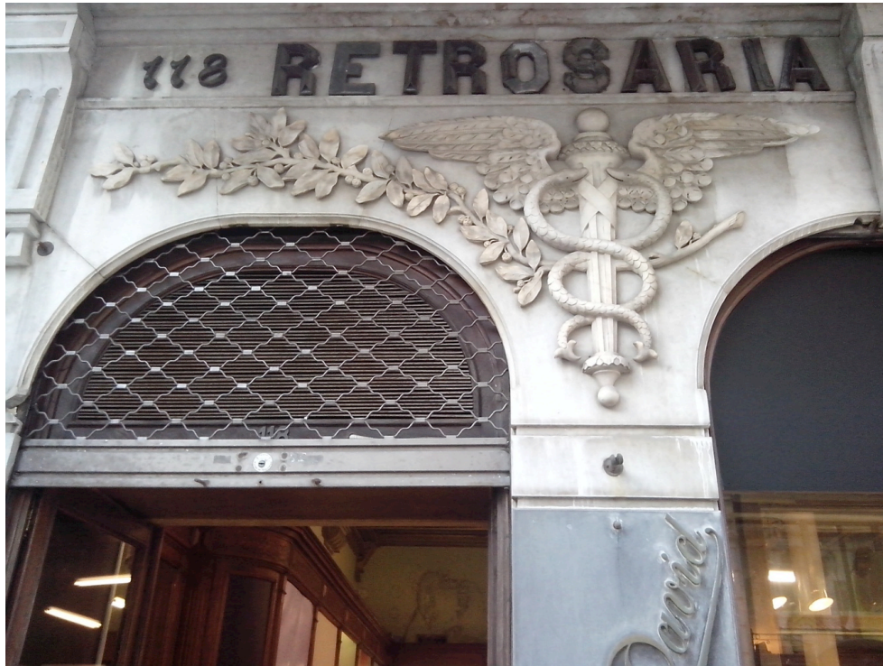
Figura 8.4 – pormenor da fachada onde o artefacto tipográfico está inserido.
