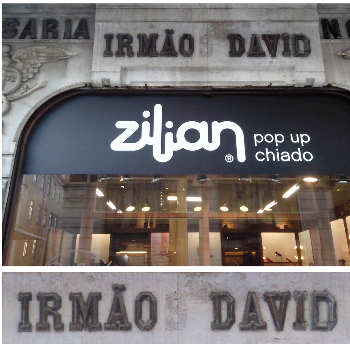
Figura 3.65 e 3.66 – Parte da fachada do espaço comercial ocupado pela Retrosaria Irmãos David, onde podemos observar os artefactos tipográficos inseridos na arquitectura.
