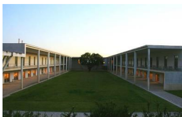
Figura 16 -Edifício da ESE
