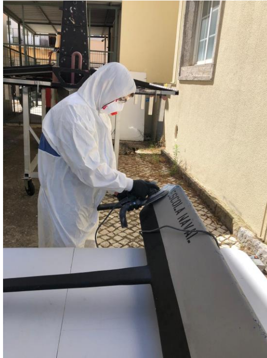
Figura 3-1 - Preparação inicial. Retiradas primeiras camadas de tinta
