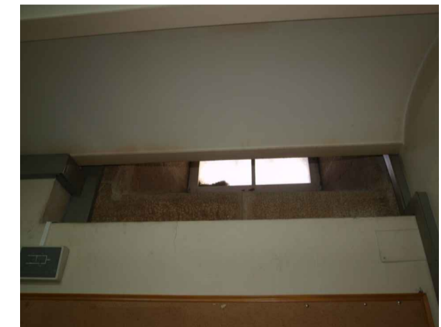
Abertura hacia el exterior.
