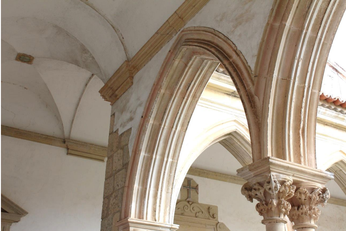
Figura 196. Tingimento de vermelho nos arcos do Claustro do Cemitério;
