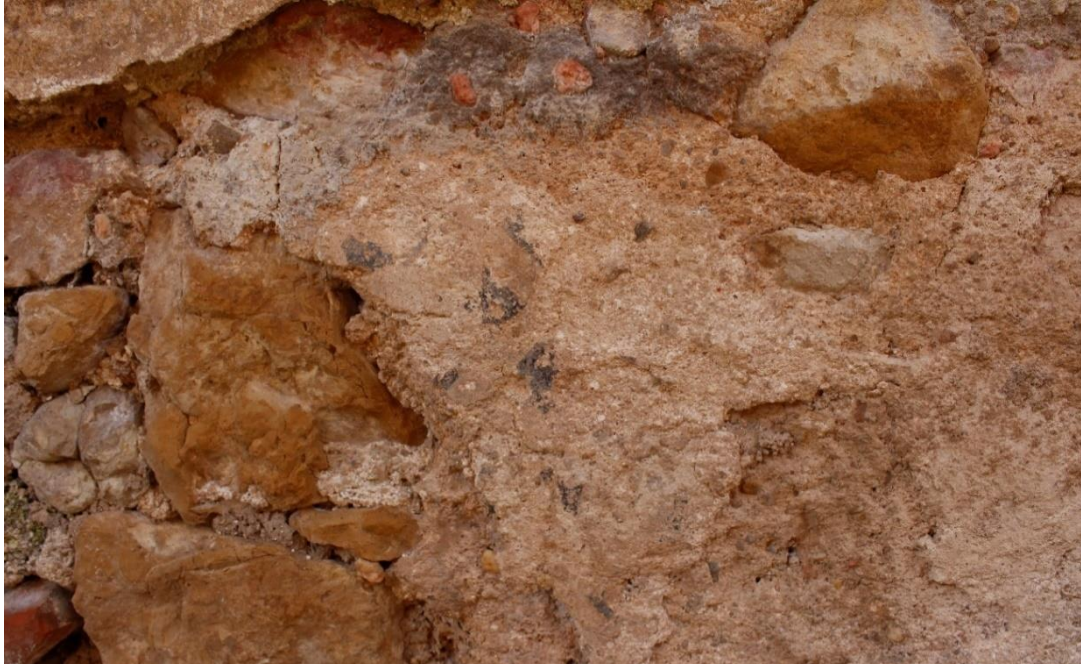
Figura 117. Vestígios de motivos negros na zona oeste do piso térreo do Paço;
