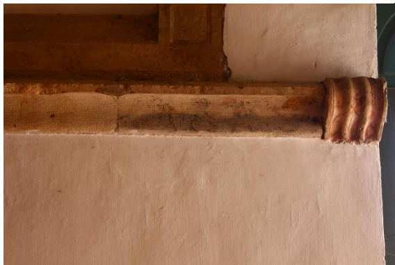
Figura 31. Vão da cantaria central da parede fundeira do refeitório com vestígios de fingidos de embutidos e marmoreado;
