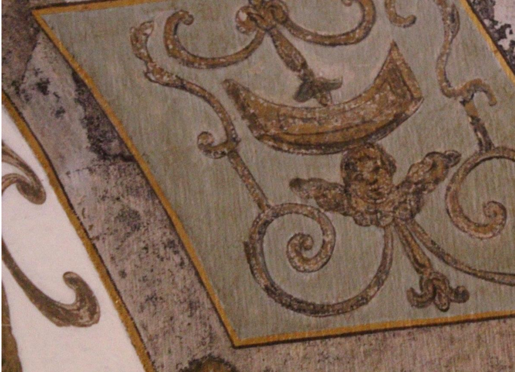
Figura 174. Irregularidades e juntas das pedras onde foram pintadas as ferronneries;
