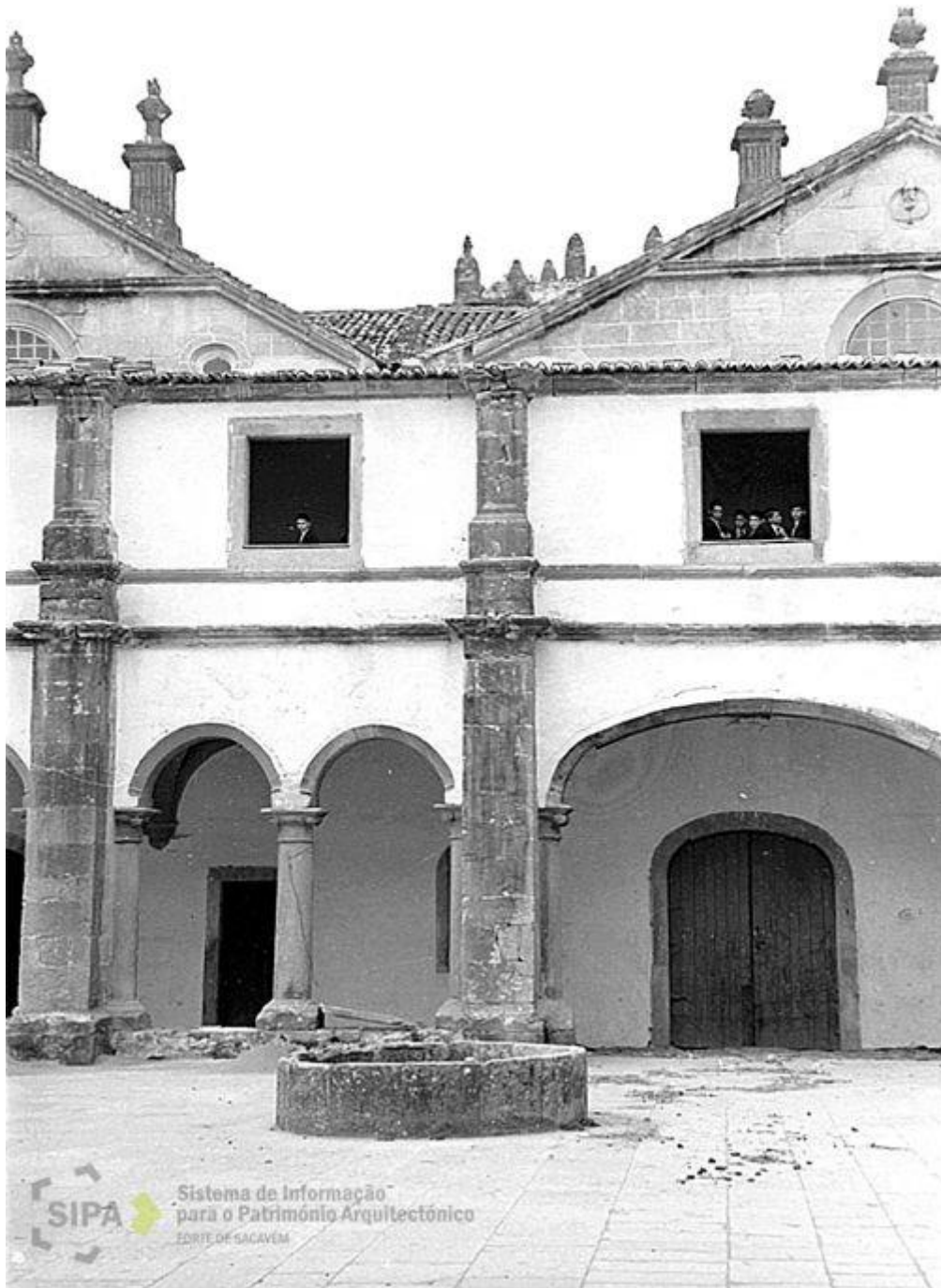
Figura 275. Frontões do Noviciado com reboco a imitar cantaria nas partes laterais, 1954. Retirado de http://www.monumentos.gov.pt/Site/APP_PagesUser/SIPA.aspx?id=4718 a 4/6/2019;
