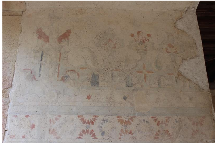
Figura 5. Platibanda gótica e barras decorativas (parede 1a);
