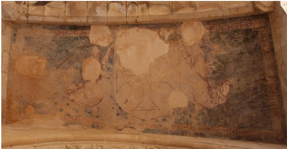
Figura 4. Pintura mural da parte superior do enxalço do janelão da Charola (antiga entrada);
