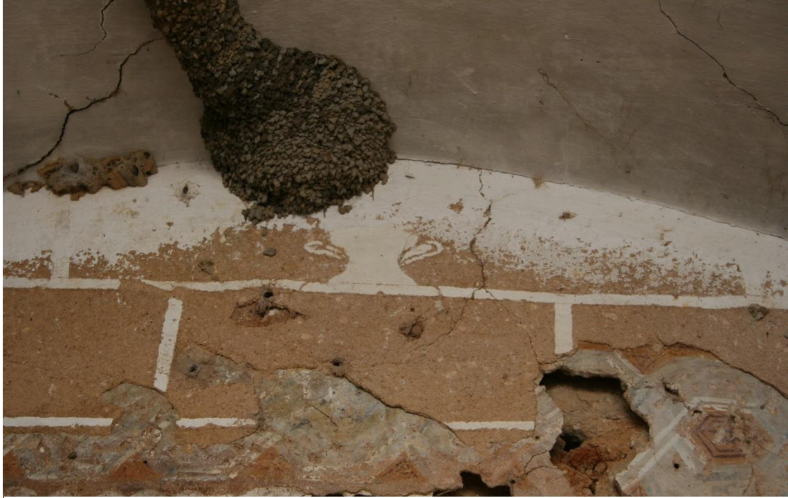
Figura 288. Reboco de imitação de cantaria com esgrafito, sobre uma pintura mural, capela-mor de uma pequena capela em Fortios, Portalegre
