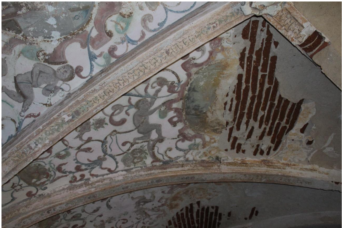
Figura 167. Grutescos com cor no teto de uma dependência do piso térreo do Convento de Nossa Senhora da Saudação, Montemor-o-Novo;
