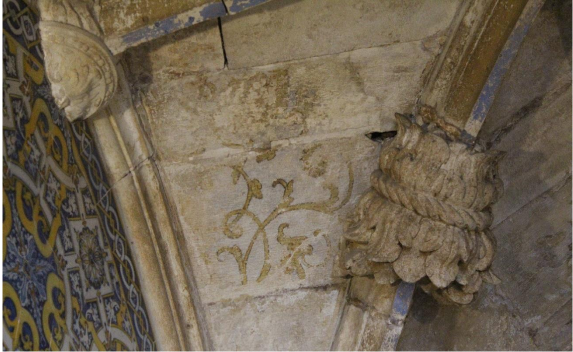
Figura 166. Vestígios de ferronneries da Capela dos Vales da Igreja de Santa Iria em Tomar;
