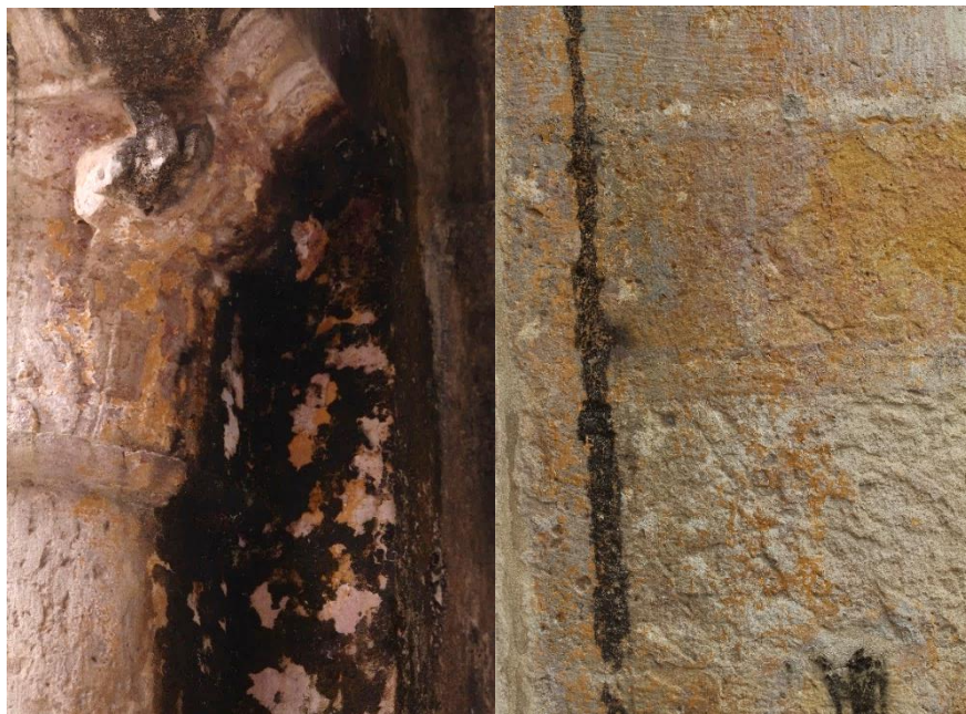
Figura 183. Vestígios de ocre nas paredes que ladeiam as colunas do Claustro da Micha;
