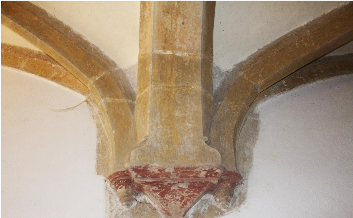
Figura 192. Nervuras e mísula laterais do corredor entre o Claustro de Santa Bárbara e o Claustro da Micha, a ocre e vermelho;
