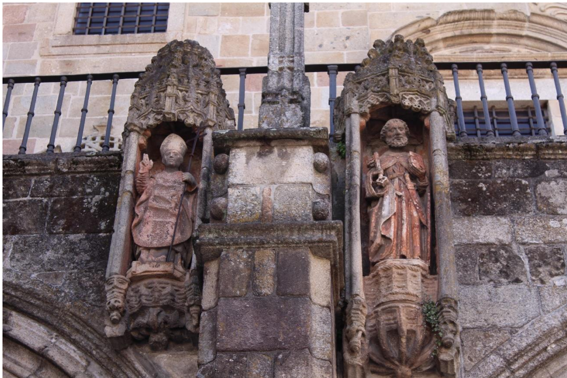
Figura 268. Duas esculturas da fachada da Sé de Braga com vestígios de vermelha;
