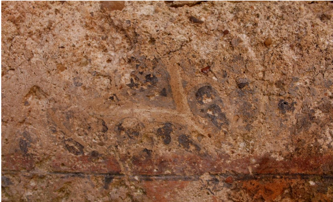
Figura 116. Pormenor dos motivos decorativos negros e brancos do muro à direita das conversadeiras do piso térreo do Paço;
