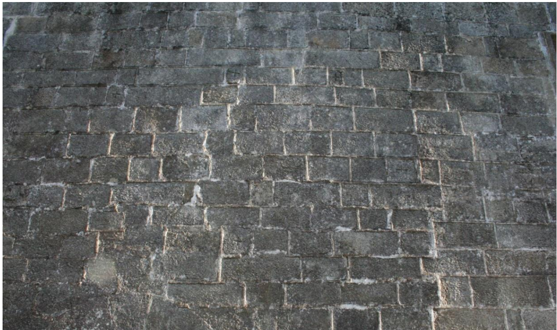
Figura 293. Exterior do aparelho de pedra regular da Igreja de S. Dinis, Vila Real, com juntas salientes. Autoria: Joaquim Caetano;
