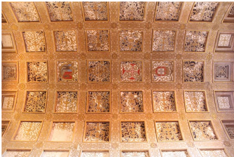
Figura 25. Vista geral do teto abobadado da Sacristia Filipina;
