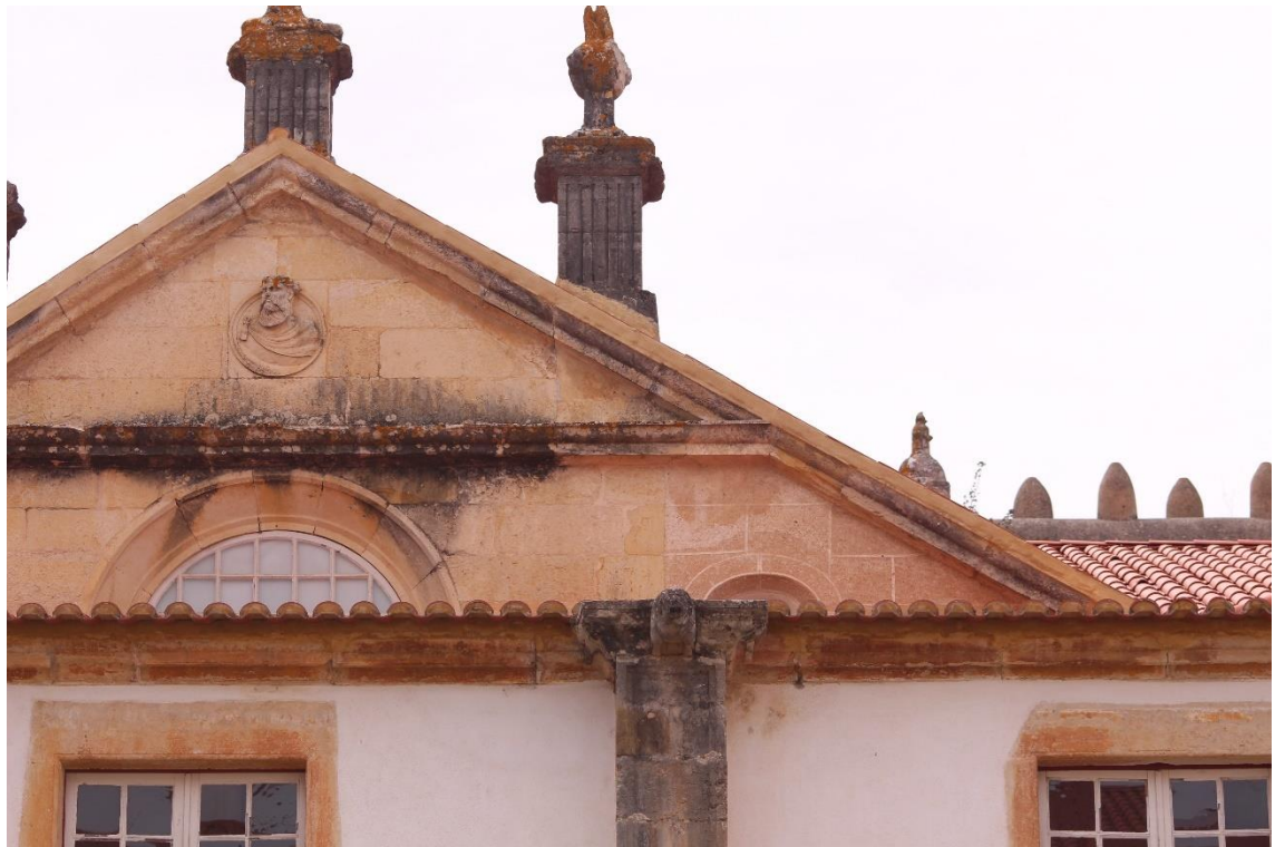
Figura 272. Zona lateral de um dos frontões do Noviciado com reboco a imitar cantaria;
