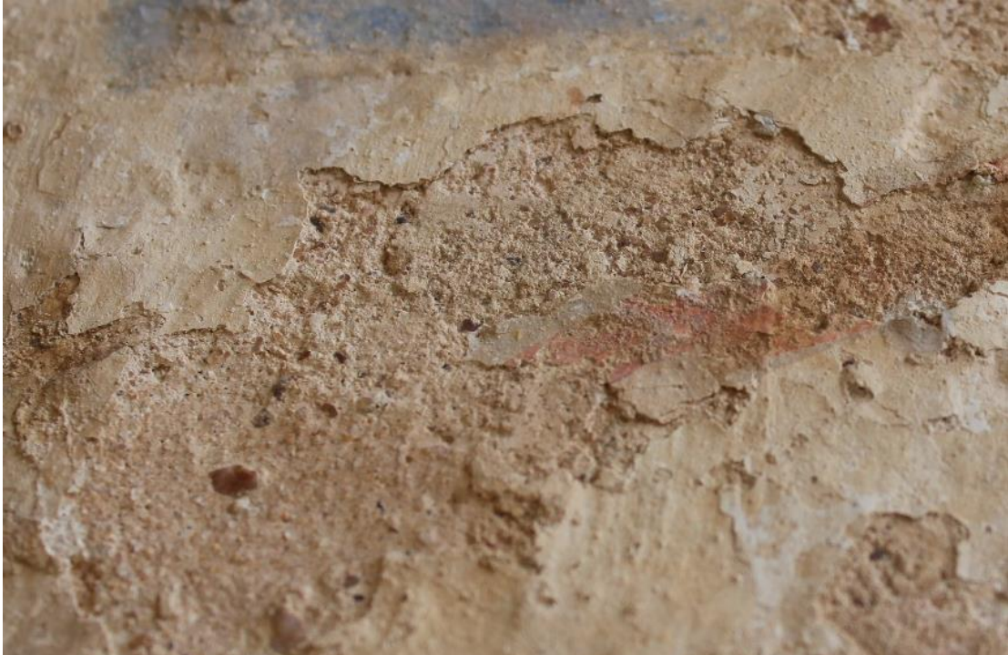
Figura 82. Camada de cal com inertes da parede 3a do lado sul;
