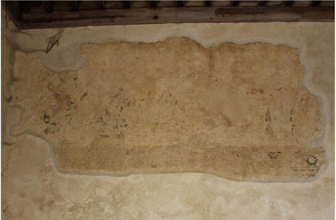
Figura 71. Vestígio da pintura da parede do lado Oeste;
