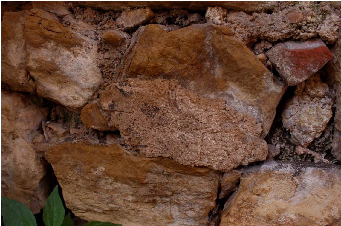
Figura 118. Fragmento de reboco ainda com motivos negros na zona oeste do piso térreo do Paço;
