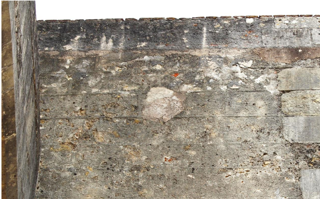
Figura 271. Reboco de imitação da estereotomia de cantaria na antiga entrada da Charola e zona da bilheteira;
