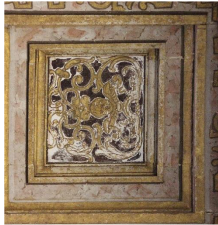
Figura 154. Caixotões de menores dimensões do teto da sacristia filipina;
