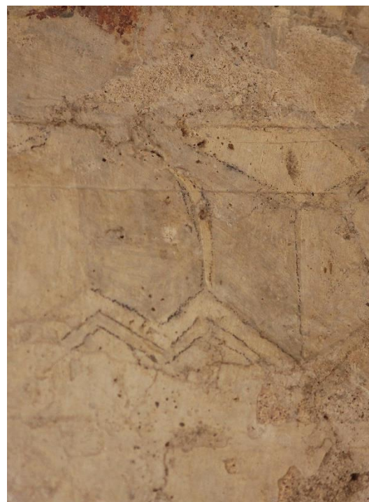
Figura 81. Linhas de contorno negras na parede 2b do lado sul;
