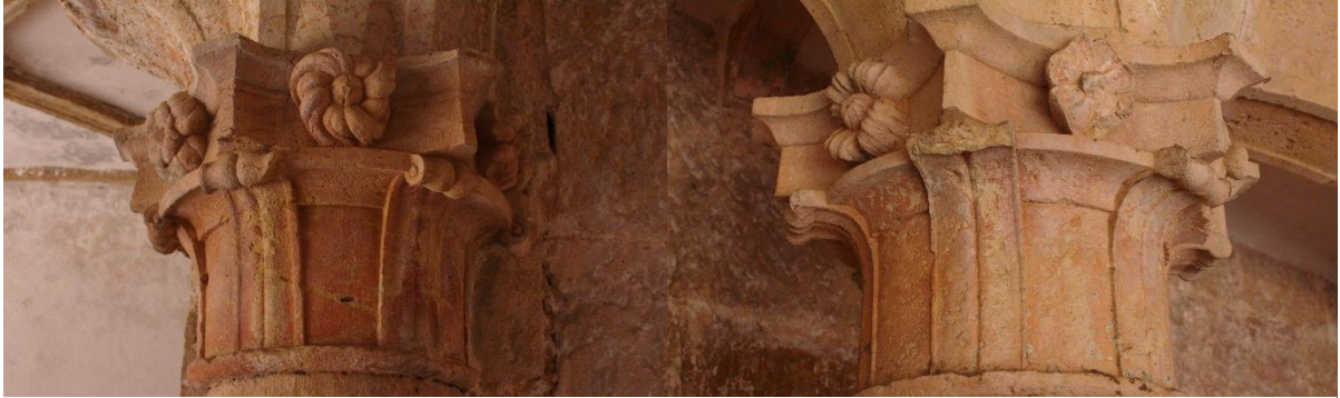
Figura 186. Vestígios de vermelho nos capitéis das colunas do lado este do Claustro de Santa Bárbara;
