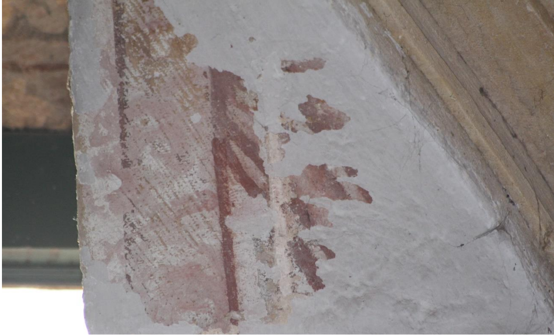
Figura 180. Pormenor do vestígio de pintura lateral à pequena janela superior, onde é visível a camada de cal e ainda as irregularidades da pedra em que a pintura foi feita;
