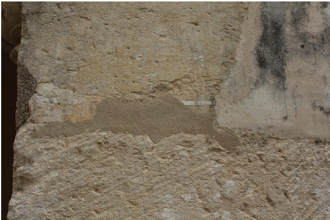
Figura 277. Junta fingida numb loco do cunhal do Claustro de Santa Bárbra;
