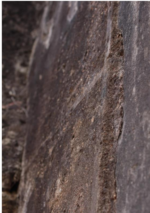
Figura 274. Reboco a imitar cantaria na parte exterior da Casa do Capítulo;
