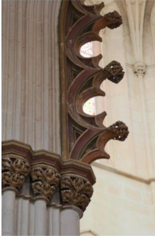
Figura 259. Pormenor dos capitéis e arco com camadas cromáticas. Aatoria: Pedro Rodrigues;
