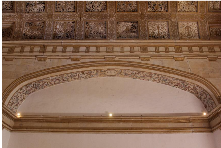
Figura 27. Vista geral do arco lateral norte da Sacristia Filipina;
