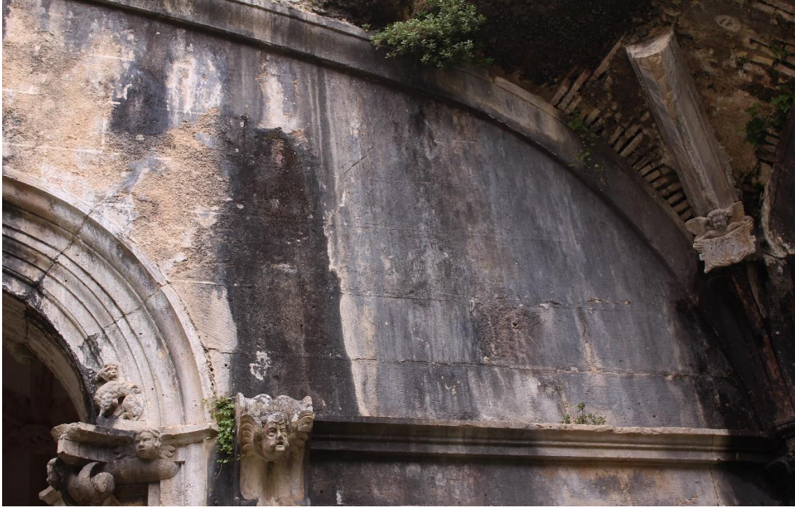
Figura 273. Vestígios de reboco a imitar cantaria no andar inferior da Casa do Capítulo inacabada;
