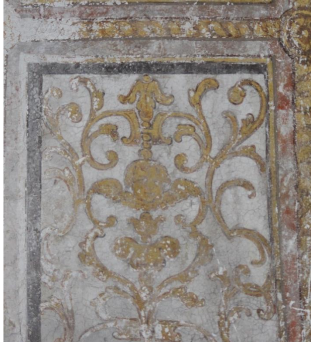
Figura 164. Caixotões com ferronneries de uma capela lateral da Igreja de São Francisco em Tomar, que partilham a expressão e composição das da Sacristia Filipina;
