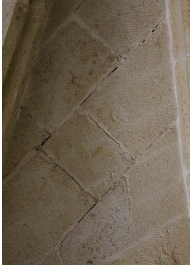
Figura 278. Pano da abóbada da Sala do Capítulo com tingimento das juntas fingidas e ainda argamassa de juntas;
