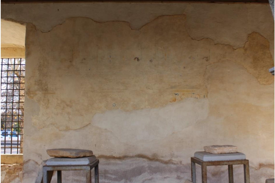
Figura 73. Vestígio da pintura da parede 2 do lado Sul;
