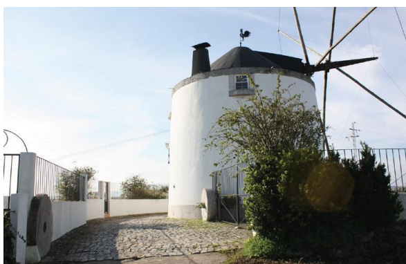
Figura. 56 - Rua dos Moinhos
